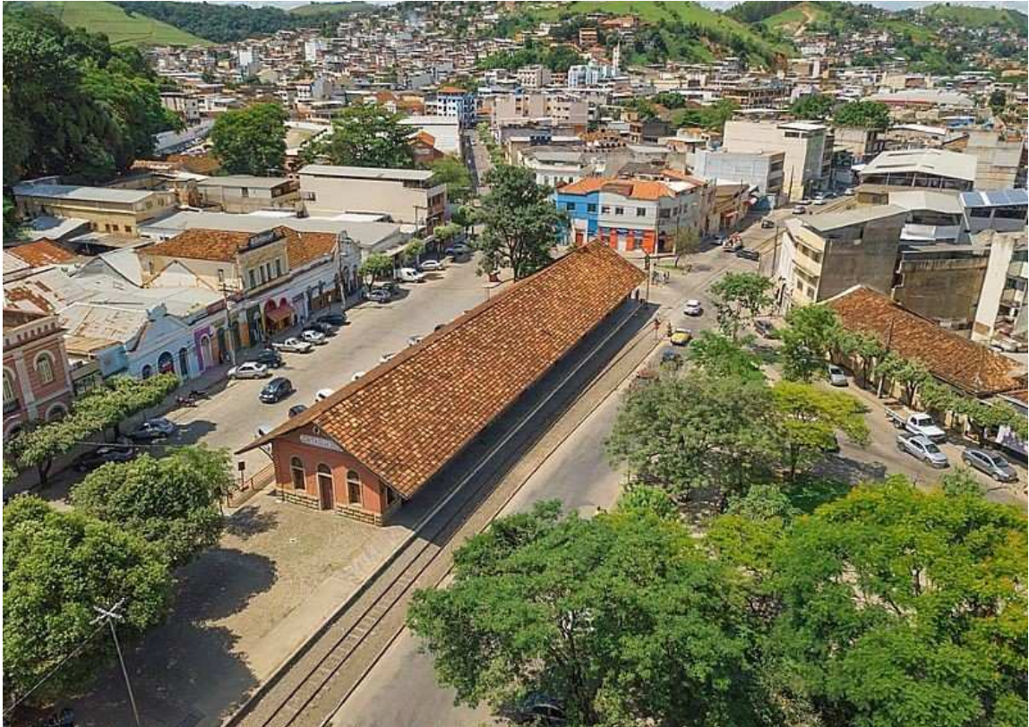
Figura 3 – Entorno da Estação Ferroviária.
