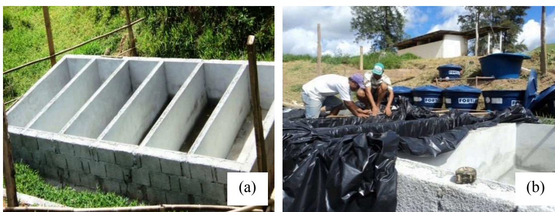
Figura 5: Tanques construídos de alvenaria (a); impermeabilização do fundo dos tanques (b).
