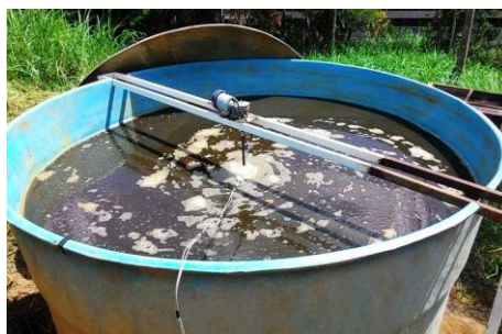
Figura 29 – Unidade piloto para condicionamento químico dos lodos
