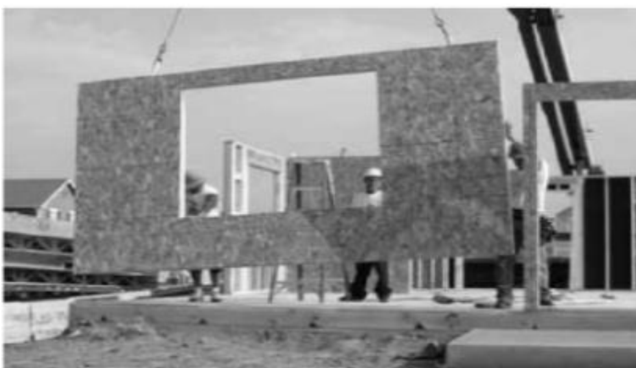
Figura 5 – Montagem de casa constituída por painéis abertos
