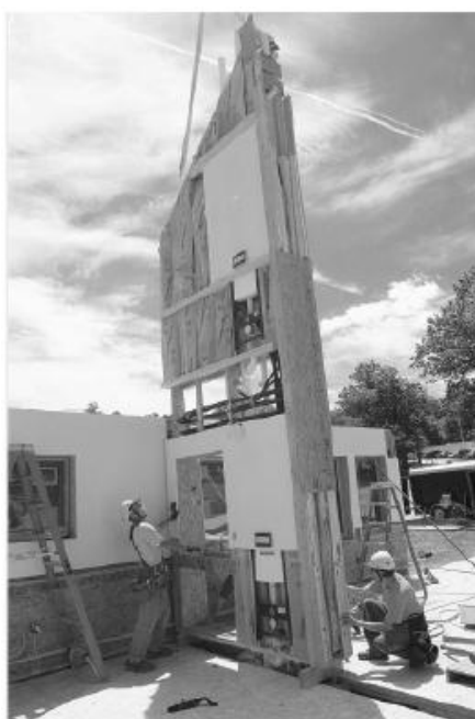
Figura 6 – Painel fechado com instalações hidráulicas
