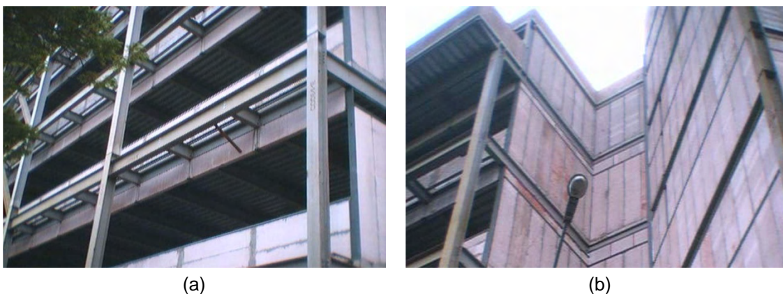
Figura 4.3 – Vistas da execução do fechamento vertical externo.
