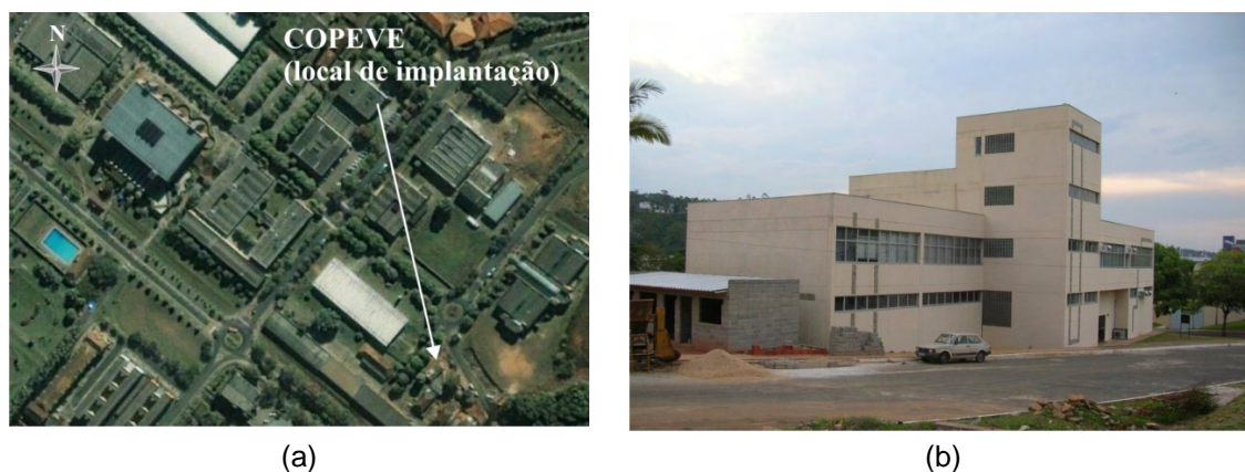
Figura 4.21 – Vistas do Edifício da COPEVE. (a) vista aérea (Fonte: http://www.google.com.br ); (b) vista externa.
