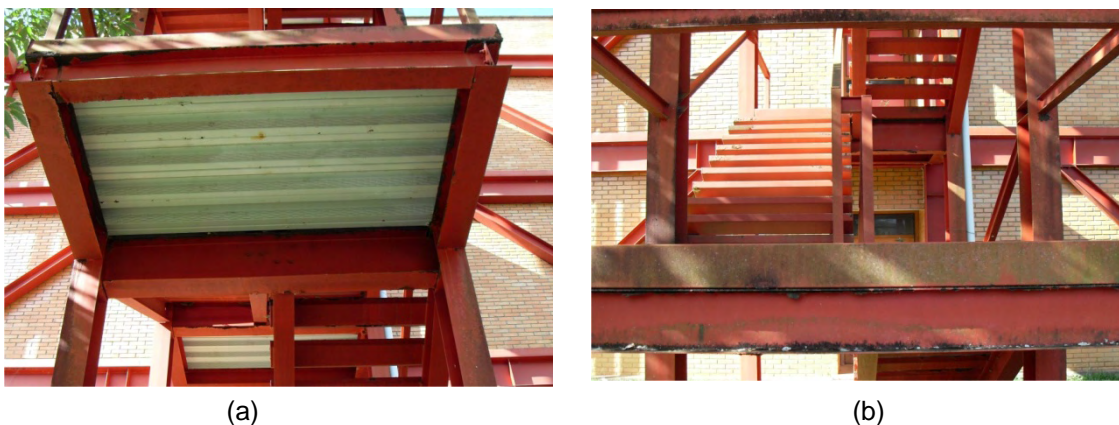
Figura 4.37 – Deterioração da escada lateral externa do edifício. (a) Corrosão devido à exposição ambiental dos degraus e do patamar; (b) corrosão da viga de aço e da chapa de arremate.
