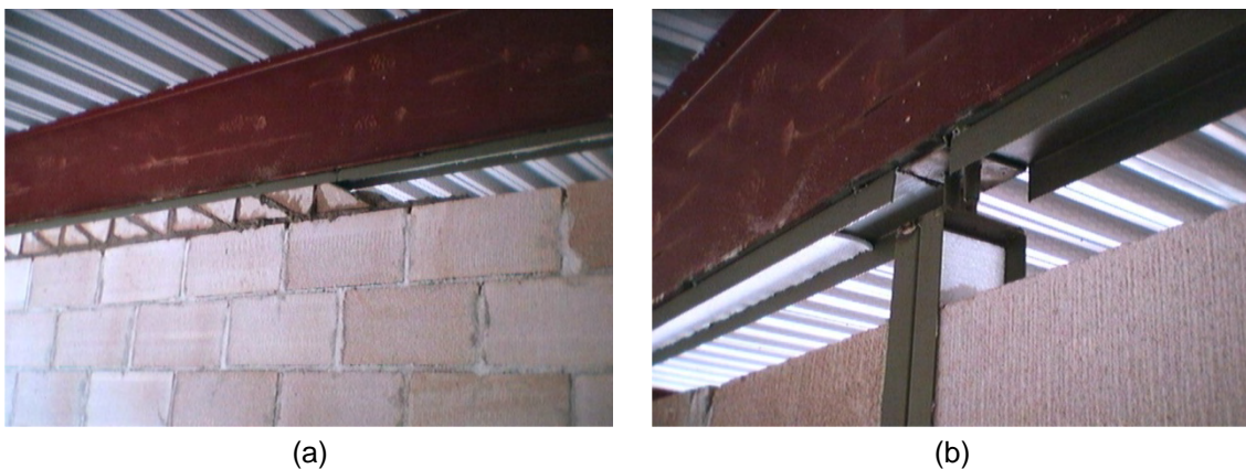
Figura 4.11 – Vistas da execução dos fechamentos do Edifício do PVB. (a) Detalhe do arremate superior das paredes; (b) estabilização do pano de alvenaria por meio de dois perfis “U” formados a frio justapostos.
