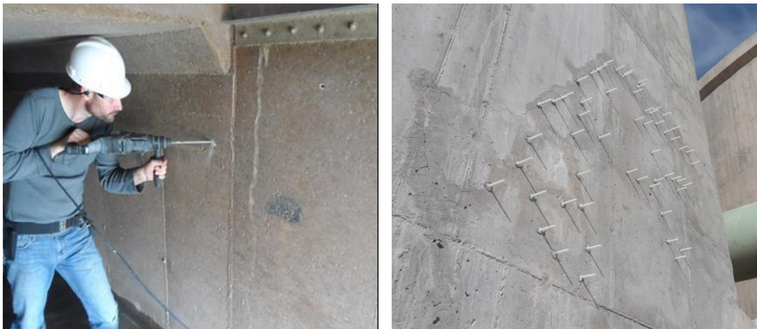
Figura 2.26 - Perfuração da estrutura e colocação dos bicos para injeção da resina.
