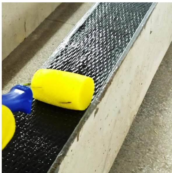
Figura 3.17 - Impregnação da manta de CFRP com a resina MC-DUR 1209.
