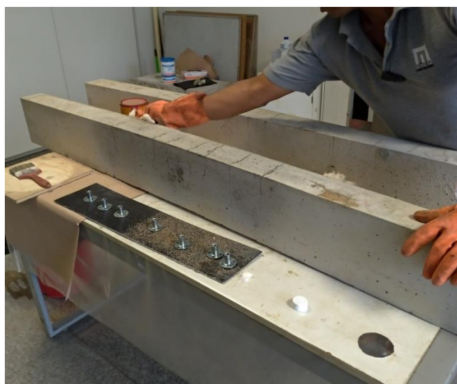
Figura 3.7 - Limpeza da área fissurada com auxílio de uma estopa com álcool.
