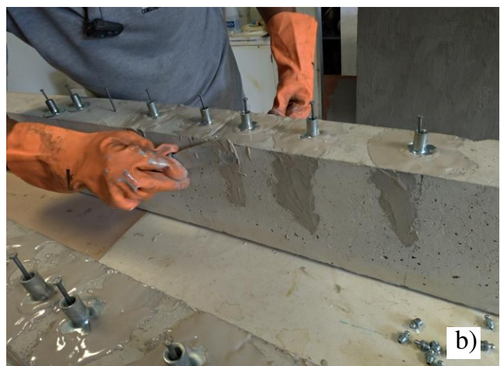
Figura 3.9 - Fixação dos bicos de adesão (a) e selamento das fissuras (b).
