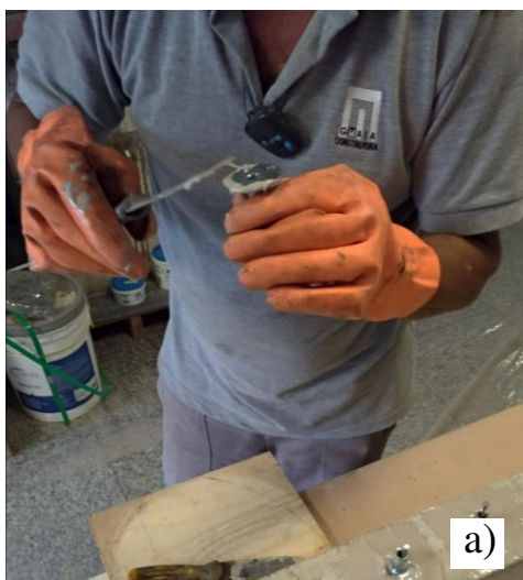
Figura 3.9 - Fixação dos bicos de adesão (a) e selamento das fissuras (b).
