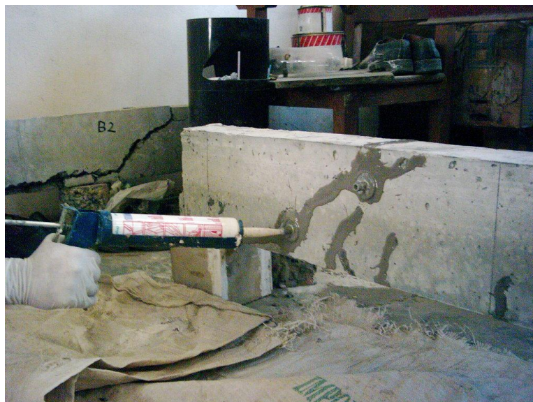
Figura 2.28 – Processo de injeção de fissuras com resina epóxi.
