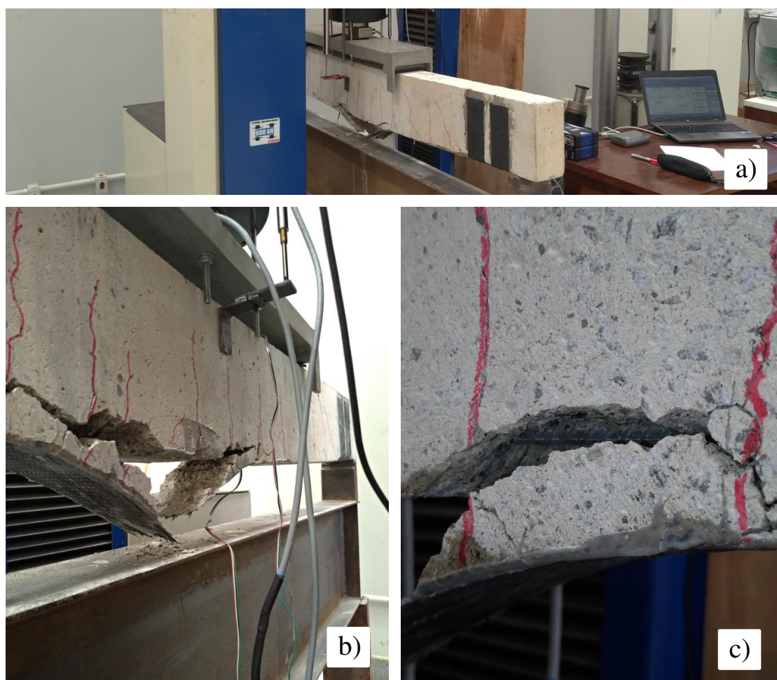
Figura 4.33 - a) Falha do modelo CRA63-IT. b) Detalhe do rompimento e descolamento da manta de CFRP. c) Detalhe do não rompimento da armadura positiva e despreendimento de fragmentos de concreto.
