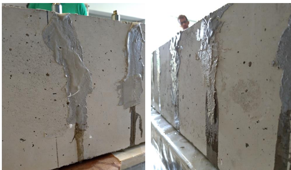
Figura 3.12 - Momento do vazamento da resina de injeção no final da extensão da fissura.
