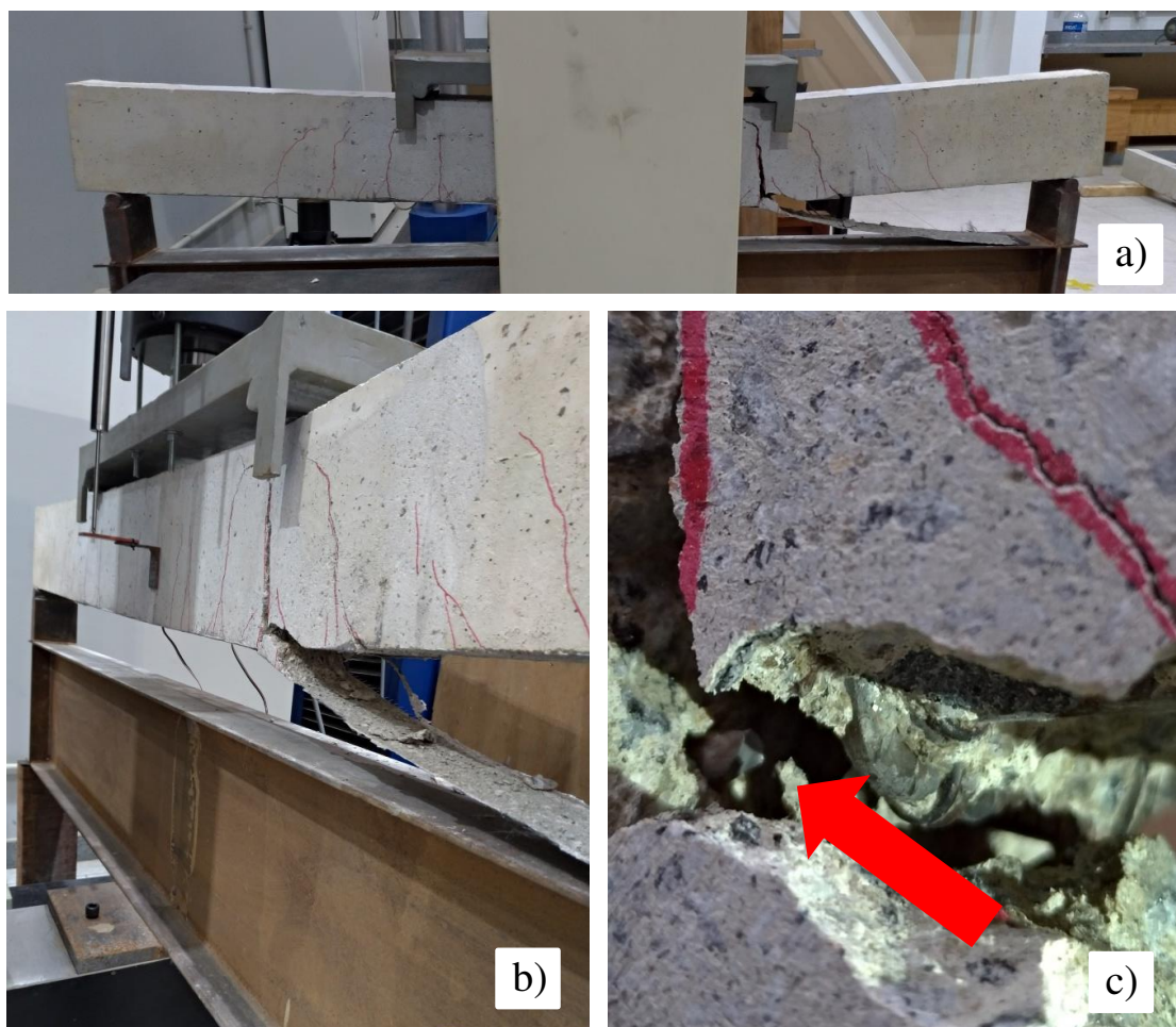
Figura 4.29 - a) Falha do modelo CRA50-IC. b) Detalhe do descolamento da manta de CFRP. c) Detalhe do rompimento da armadura positiva.
