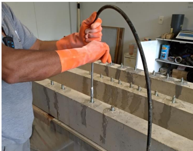
Figura 3.11 - Fixação do bico da mangueira ao bico de adesão colado sobre uma fissura.
