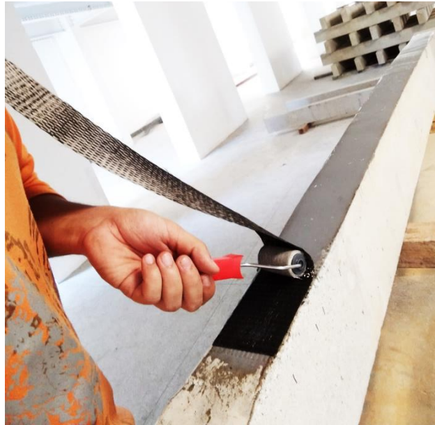
Figura 3.16 - Fixação da manta de CFRP.
