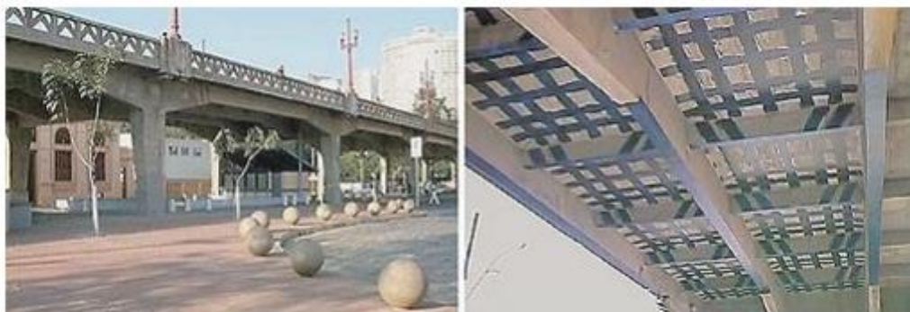
Figura 2.19 - Primeiro registro de utilização de CFRP na América Latina – Viaduto de Santa Tereza em Belo Horizonte, MG.
