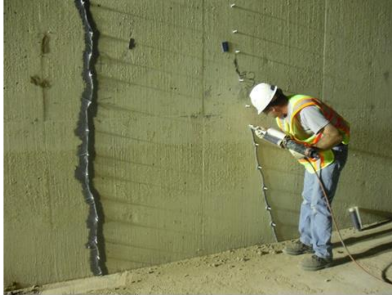
Figura 2.27 - Vedação das fissuras.
