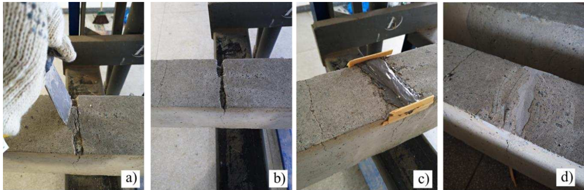
Figura 3.13 - a) Retirada dos fragmentos soltos; b) viga com os fragmentos retirados; c) preenchimento com o Viapoxi Adesivo; d) Regularização da superfície.
