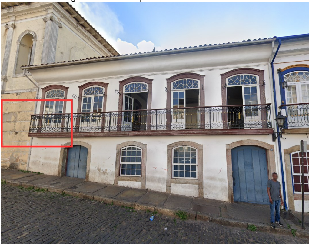
Figura 18 - Pássaro: panorama do edifício 2 - 2023
