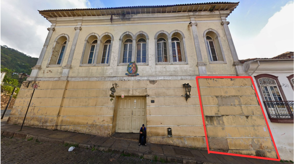
Figura 17 - Pássaro: panorama do edifício 1 - 2023
