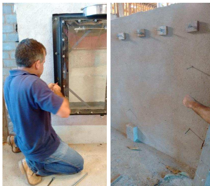
Figura 67 - Fixação da câmara na parede.
