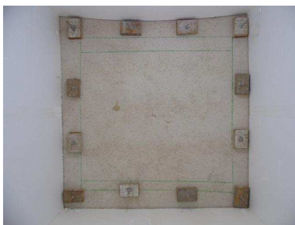
Figura 59 - Tarugos de madeira posicionados no lado interno da parede.
