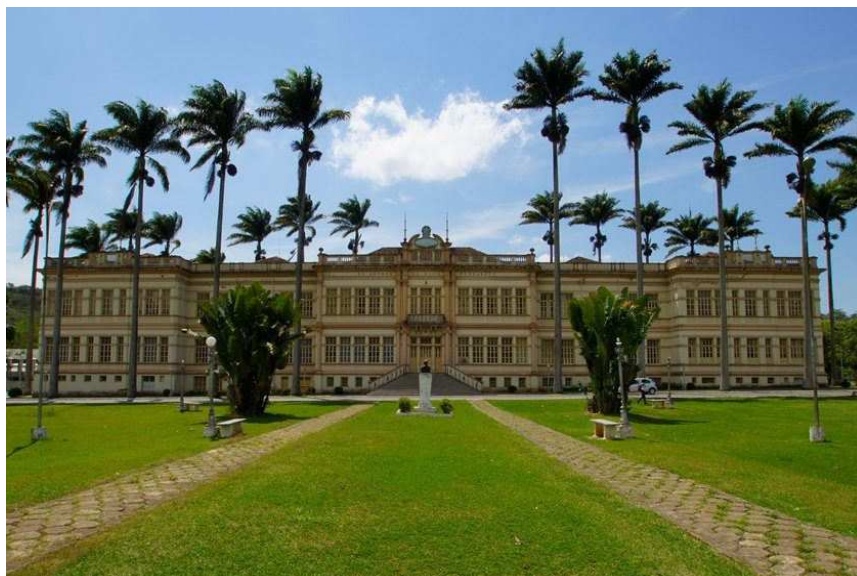
Figura 9: Edifício Arthur Bernardes.
