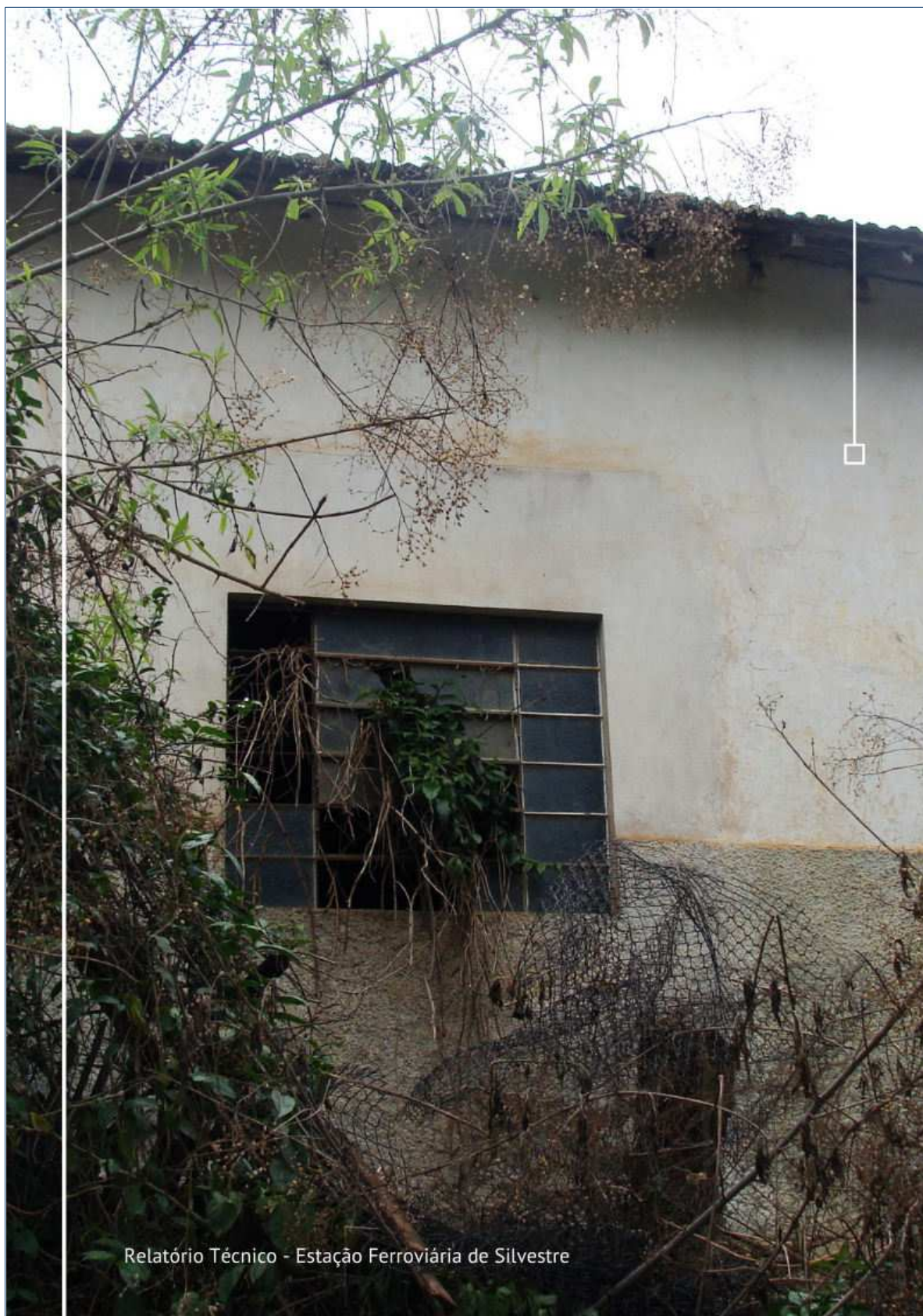
Figura 34: Foto Janela Lateral da Estação. Fonte: Relatório Técnico - Estação Ferroviária de Silvestre.
