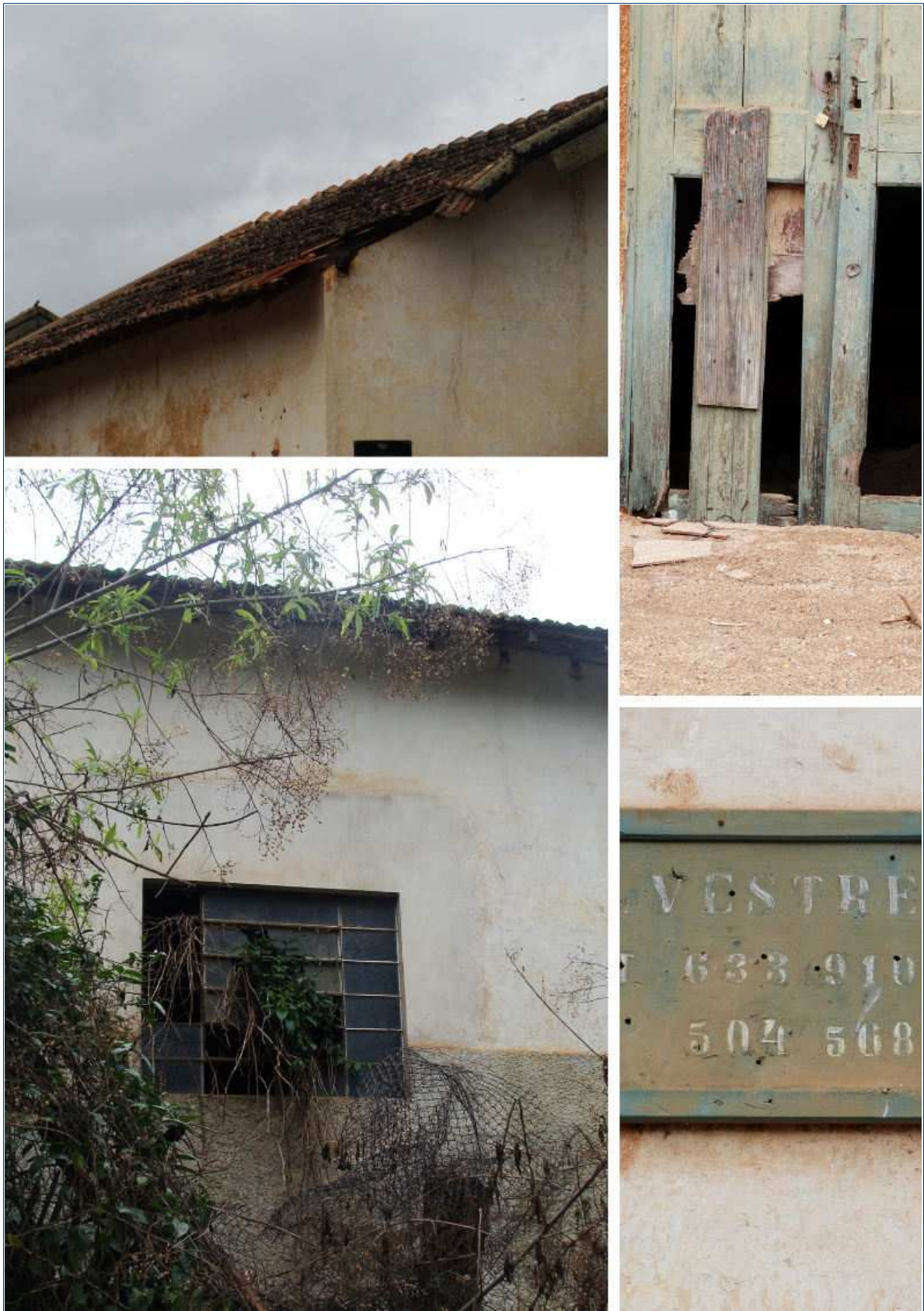
Figura 36: Contracapa. Fonte: Relatório Técnico - Estação Ferroviária de Silvestre.
