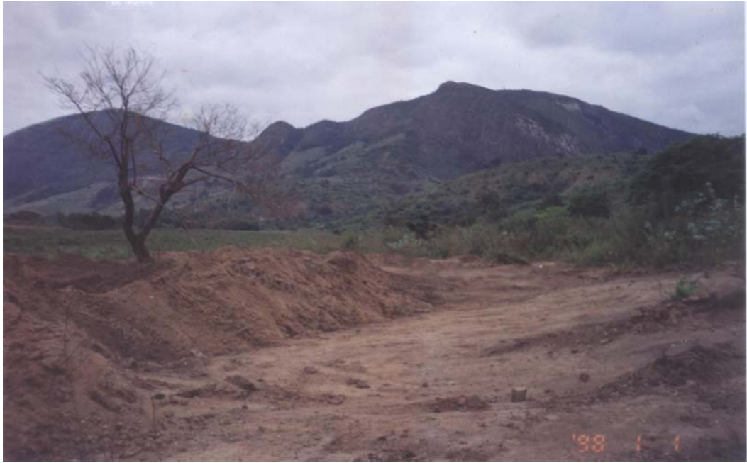
Figura 3 - Represa de contenção antes do início da estação chuvosa.
