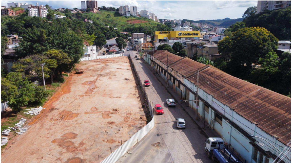
Figura 22 - A imagem tirada por drone mostra o Conjunto da Praça da Estação. Os três principais edifícios e suas respectivas escalas no desenho urbano
