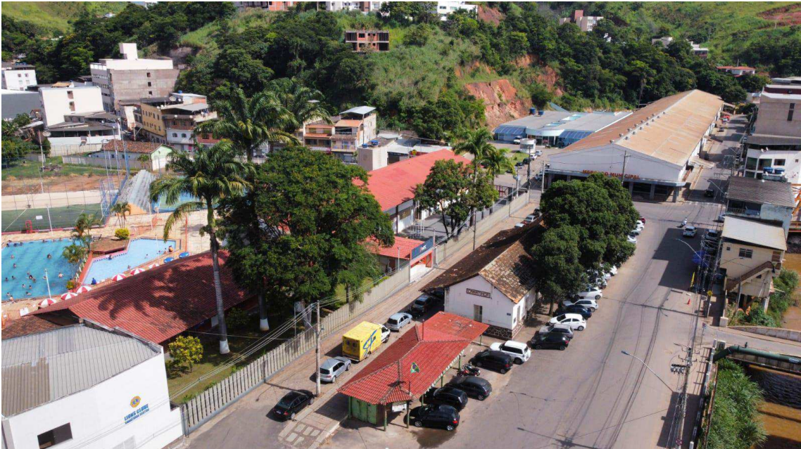
Figura 19 - A imagem tirada por drone mostra o Conjunto da Praça da Estação. Os três principais edifícios e suas respectivas escalas no desenho urbano
