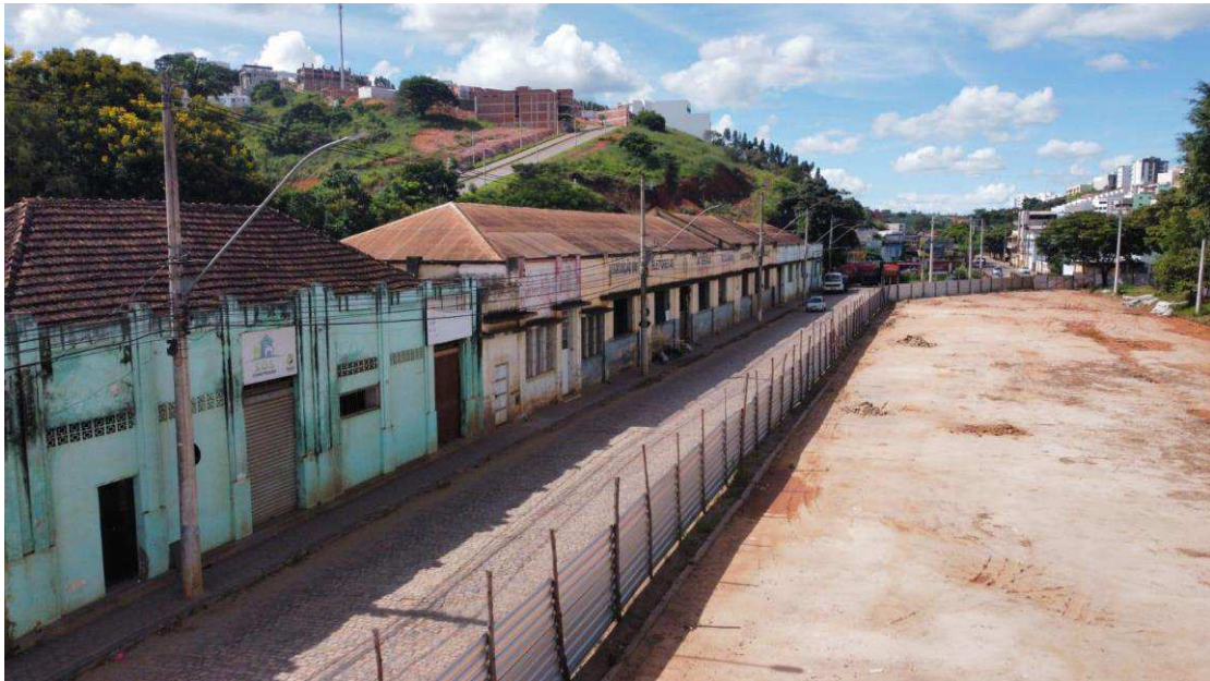
Figura 24 - A imagem tirada por drone mostra o Conjunto da Praça da Estação. Os três principais edifícios e suas respectivas escalas no desenho urbano
