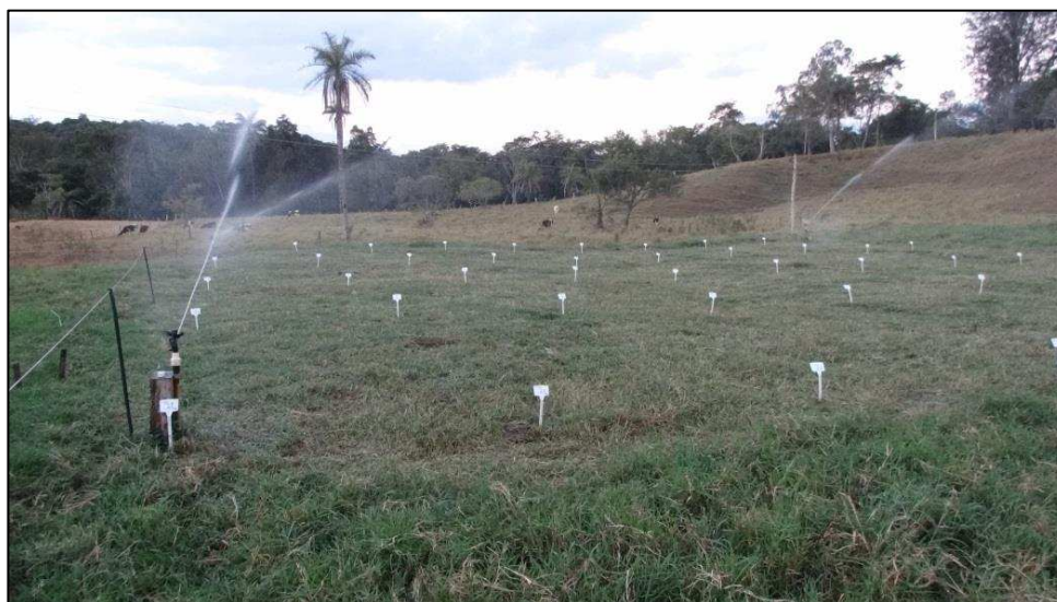
Figura 19 – Sistema de irrigação automatizado em funcionamento.
