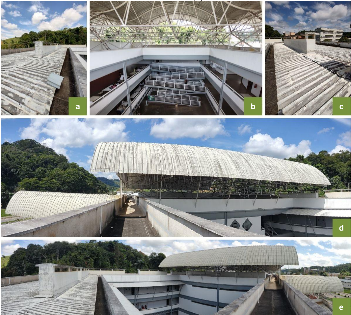
Figura 2.3 – Cobertura do PVB atual. Cobertura das salas de aula laterais (a e c); cobertura do pátio (b); cobertura da entrada do edifício, de parte do corredor e do pátio (d); cobertura das salas de aula à esquerda, do corredor, do pátio e da entrada do edifício (e)
