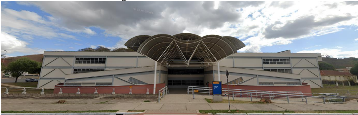
Figura 4.2- Pavilhão de Aulas II
