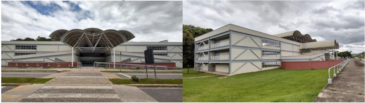
Figura 2.1 – Pavilhão de Aulas II
