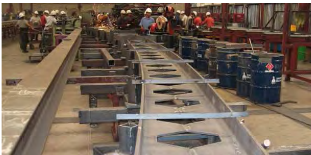
Figura 59 – Fabricação da viga castelada curva (fonte: http://www.steelssalg.com – acessado em 10/12/2011).
