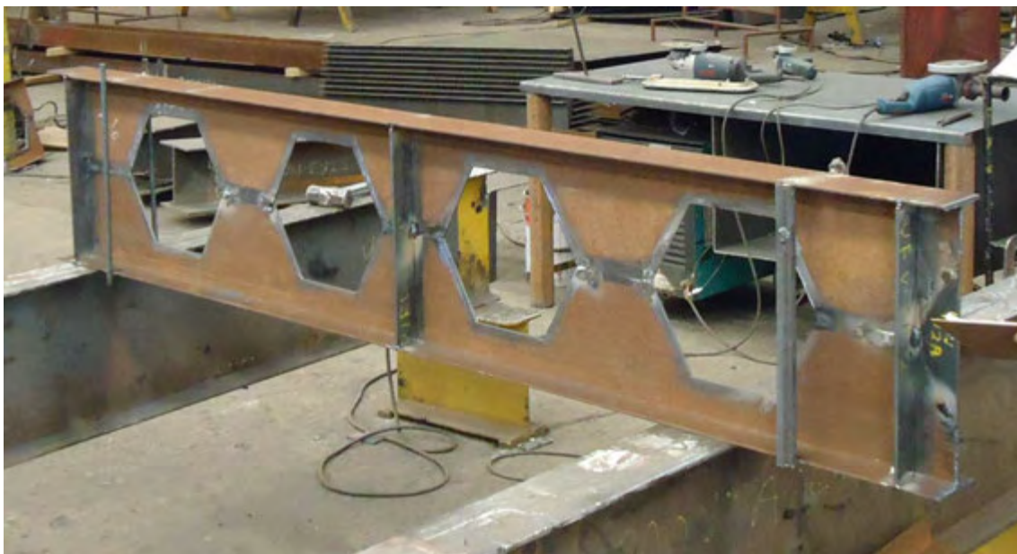
Figura 54 – Viga castelada após pré-montagem, aguardando soldagem final (foto: Washington Vieira).
