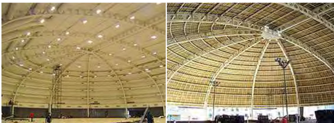
Figura 73 – Centro de eventos no edifício WTC (fonte: Revista Técnica, nº 164, 2010).
