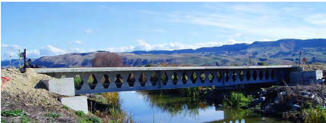
Figura 78 – Ponte rodoviária em viga castelada mista – Nova Zelândia (fonte: www.latteycivil.co.nz – acessado em 22/02/2012).
