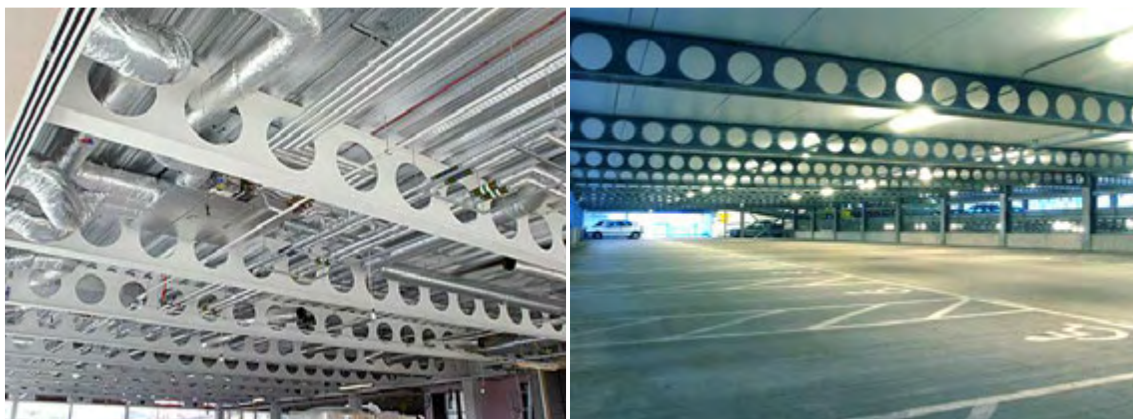
Figura 63 – Whitehall Road, Leeds, 18,5 m; e Cambridge Car Park, 16 m (fonte: www.westok.co.uk – acessado em 11/05/2011).
