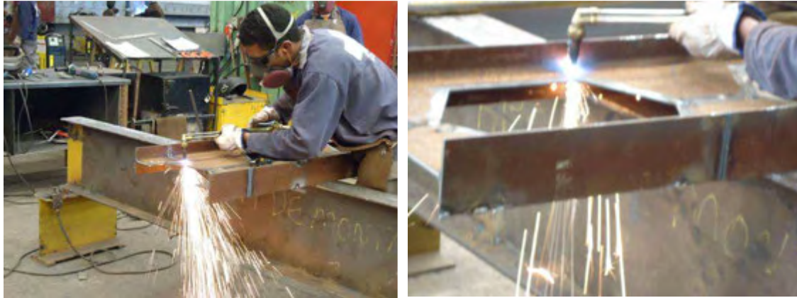
Figura 53 – Corte das porções excedentes da viga (foto: Washington Vieira).
