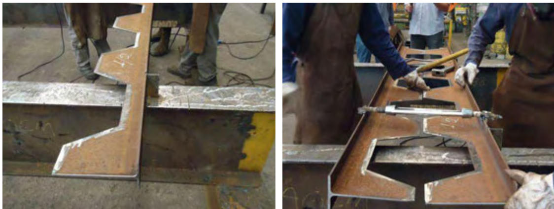
Figura 52 – Junção das metades e alinhamento dos montantes (foto: Washington Vieira).
