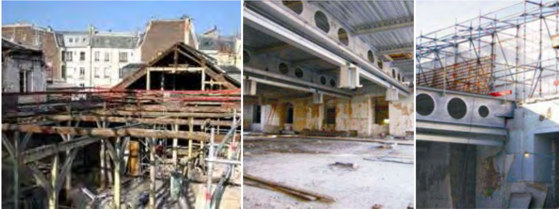
Figura 83 – Antiga estrutura de madeira e nova estrutura em aço (fonte: www.constructalia.com – acessado em 13/12/2011).
