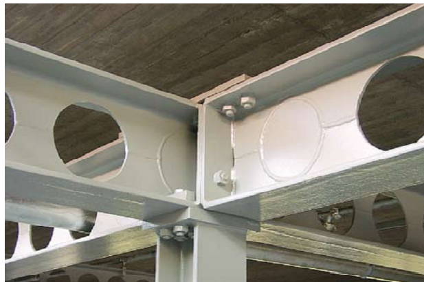
Figura 86 – Fechamento do alvéolo (fonte: www.arcelormittal.com – acessado em 13/12/2011).
