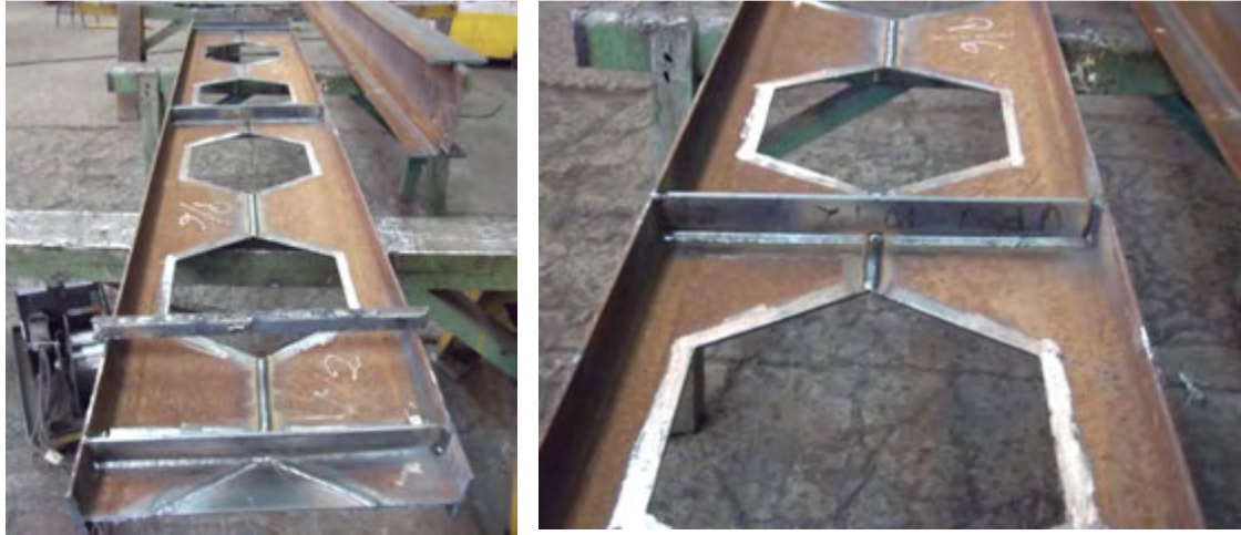
Figura 55 – Aspecto da viga após a soldagem final (foto: Gustavo Veríssimo).
