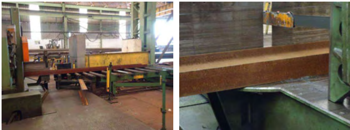
Figura 46 – Corte do perfil laminado vindo de fábrica (foto: Washington Vieira)
