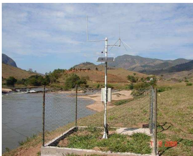
Figura 14 – Estação hidrometeorológica no entorno da PCH Cachoeirão (LIMIAR, 2012).
