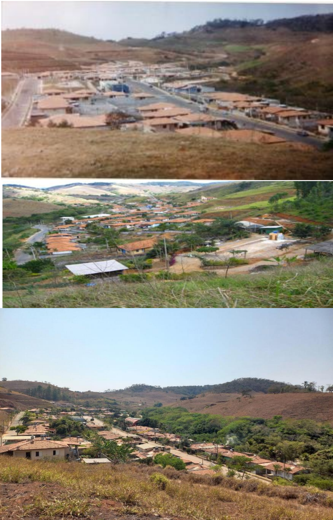
Figura 12 – Vista panorâmica do reassentamento
