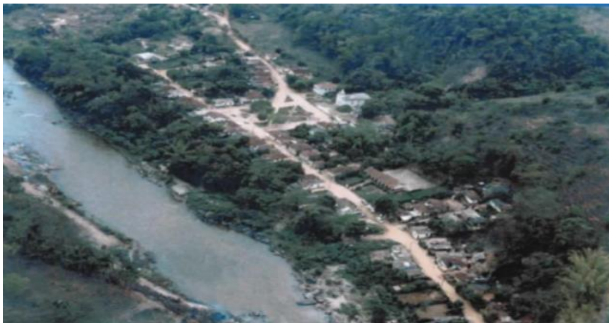
Figura 5 – Vista panorâmica da comunidade de São Sebastião do Soberbo antes da inundação
