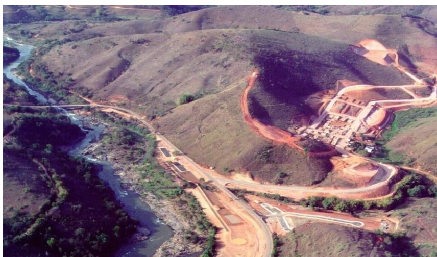
Figura 3 – Distrito de Nova Soberbo em fase inicial de construção. Identificação da rodovia e da entrada principal do distrito
