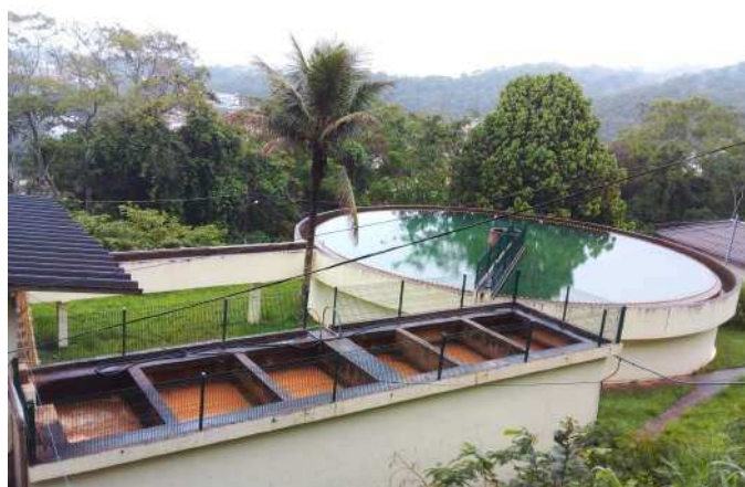
Figura 8. Decantador e filtros da Estação de Tratamento de Água da UFV.
