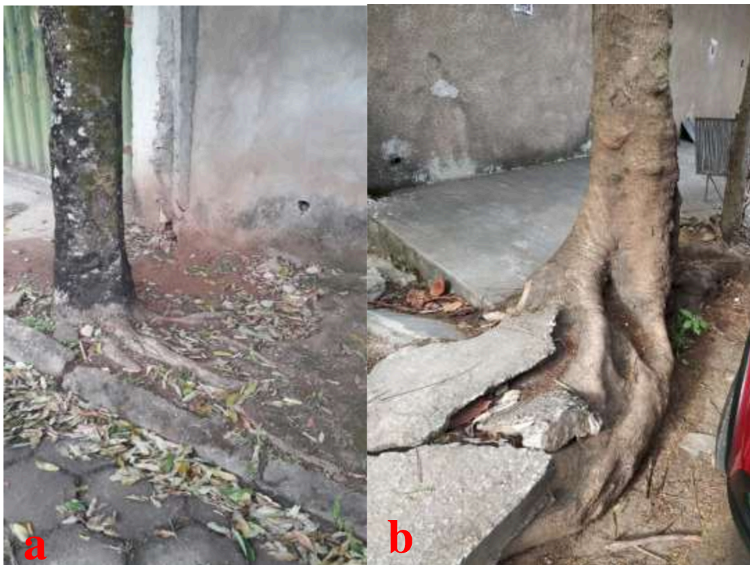
Figura 14 – Exemplos de indivíduos com problemas entre raízes e calçadas. a) classificado como raízes superficiais. b) classificado como danificando as calçadas.
