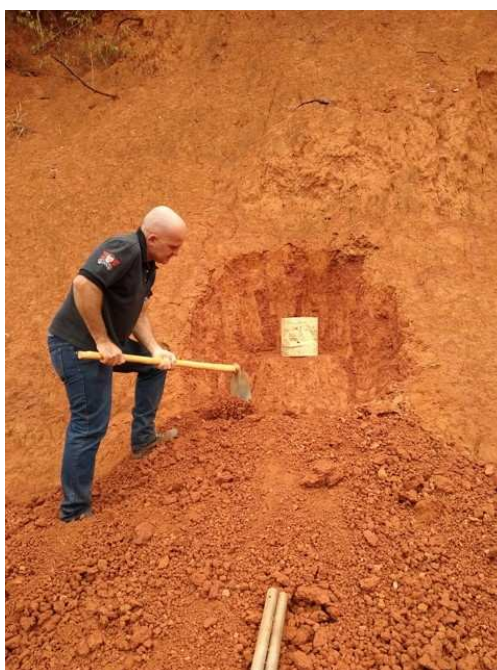
Figura 5: Vista do talude e do local de coleta das amostras de solo.
