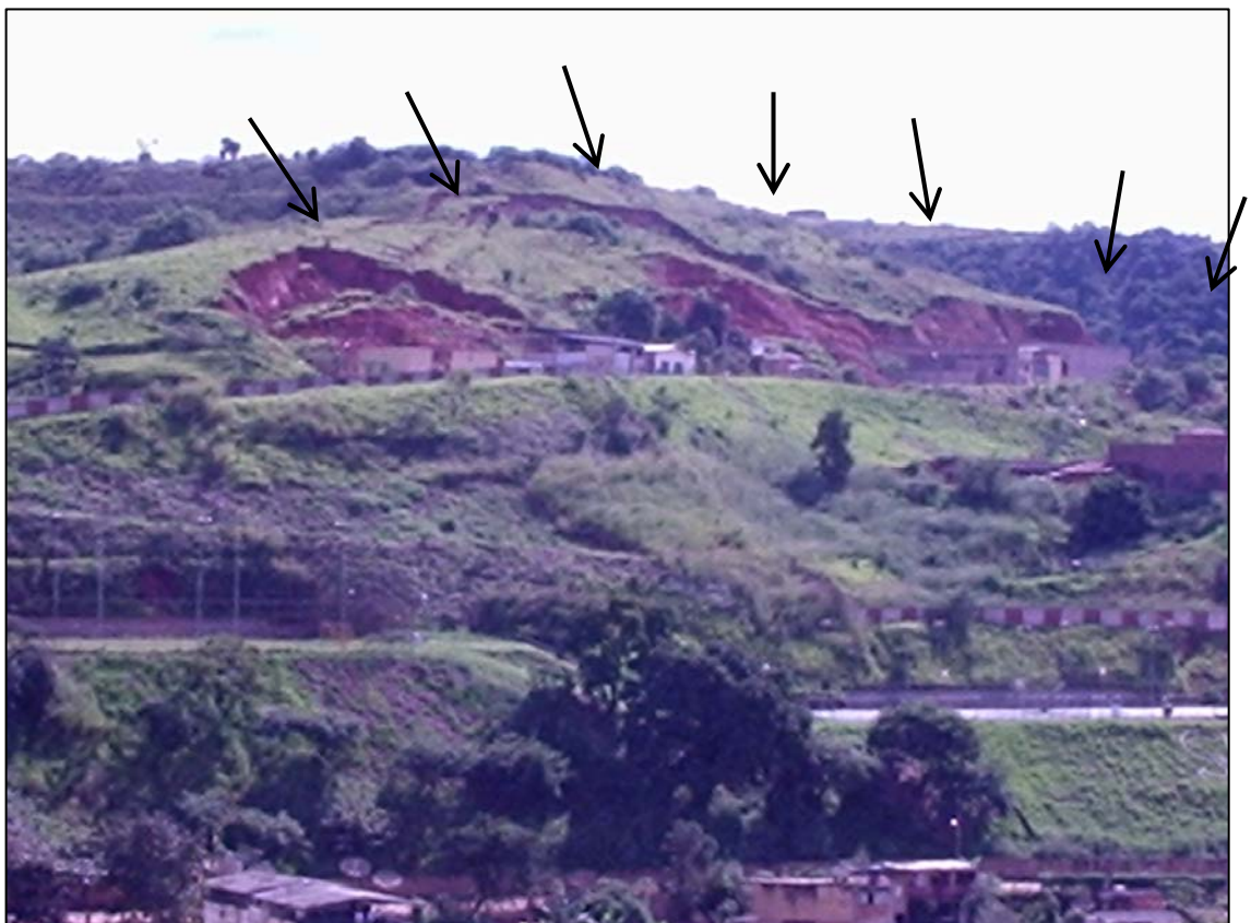
Figura 22 – Vista geral do talude
