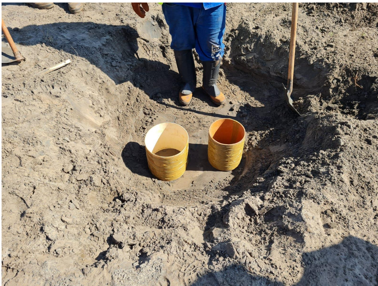
Figura 4.1 – Abertura de poço de inspeção.
