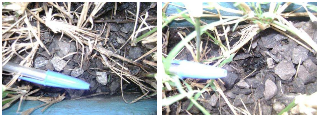
Figura 21. Buracos observados na superfície do leito dos SACs-EHSS.
