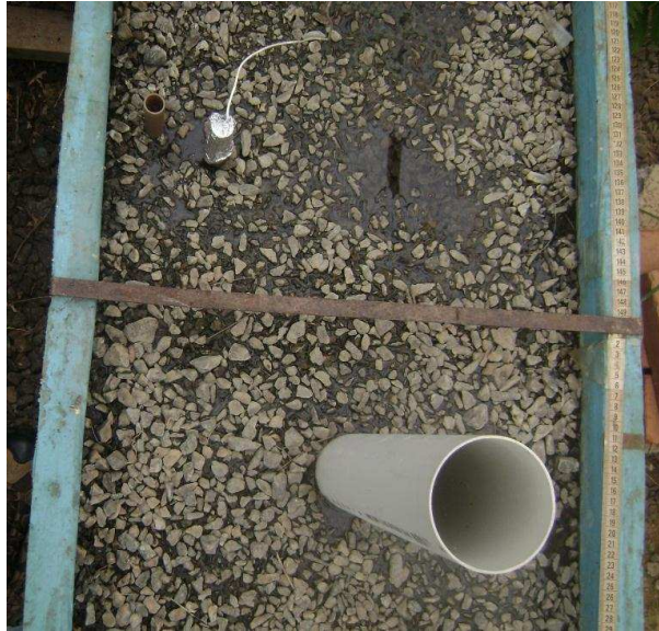
Figura 29. Presença de afloramento da água no SAC-EHSS 4NI.
