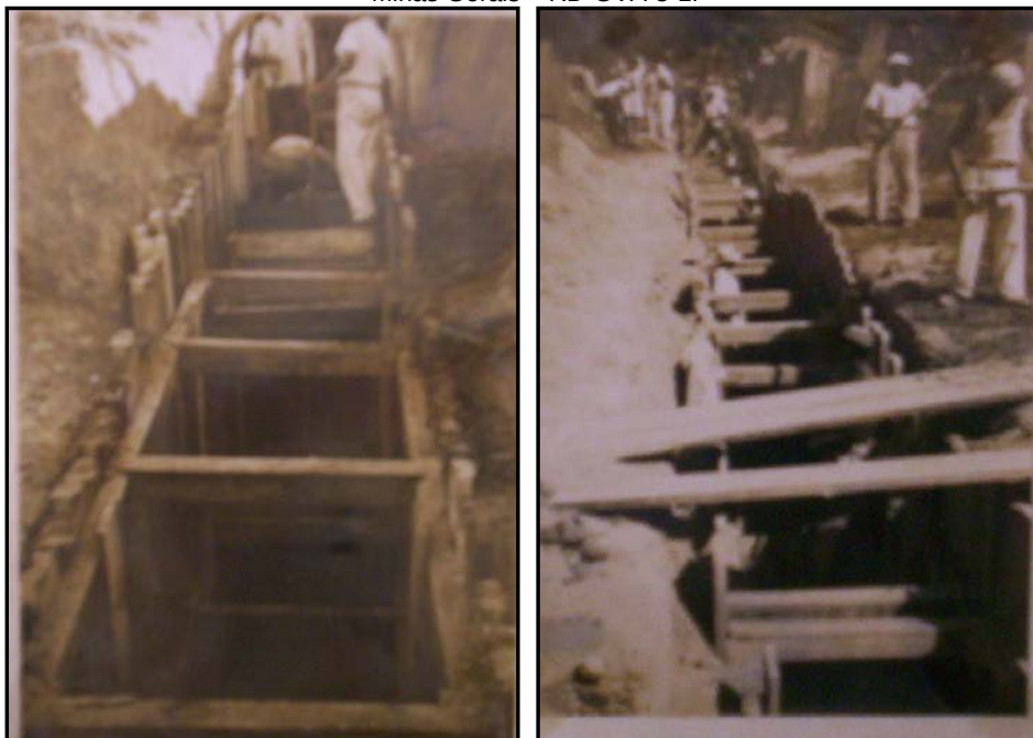
Figuras 3.4 e 3.5 – Modificação do Sistema de Esgotos Sanitários – Governador Valadares – Minas Gerais – RD-GVA-8-1.
