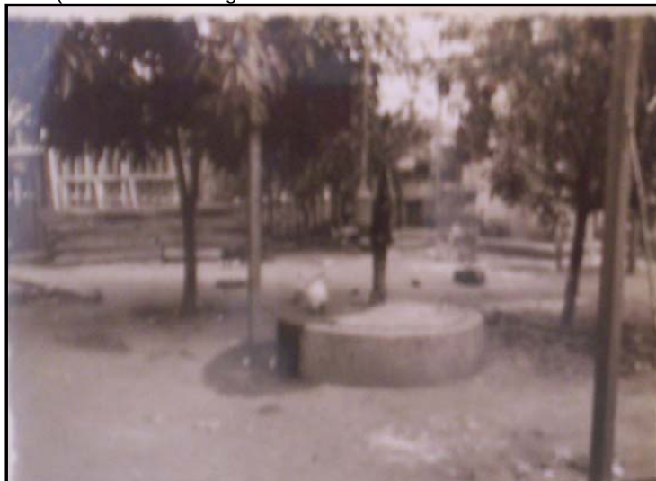
Figura 3.7 – Private well water supply at corner of Rua 55 and Rua Afonso Pena. April, 1945. (Reservatório de água localizado entre as Ruas 55 e Afonso Pena)
