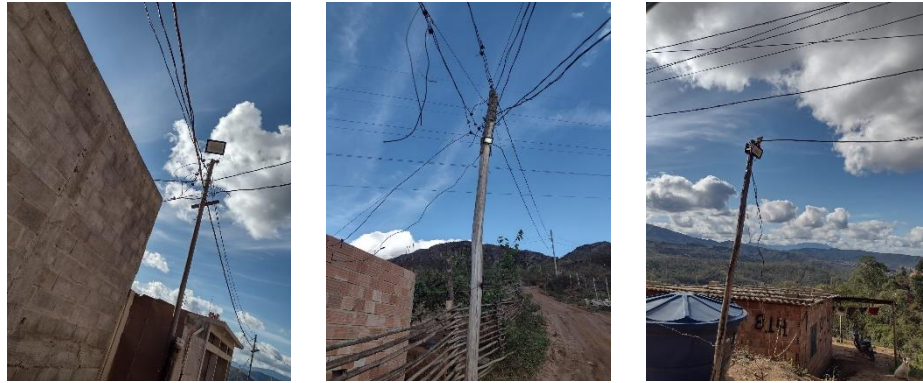
Figura 13 - Adequações na iluminação das ruas realizada pelos moradores.
