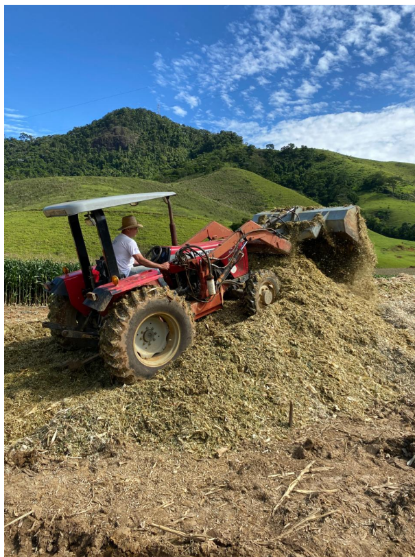
Figura 6 – Compactação mecanizada da matéria
