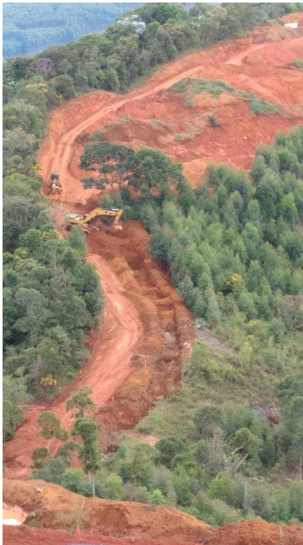
Figura 20 - Manutenção nos poços de decantação e fechamento de acesso de um corpo de mineração de bauxita. Rosário da Limeira-MG, 2017.
