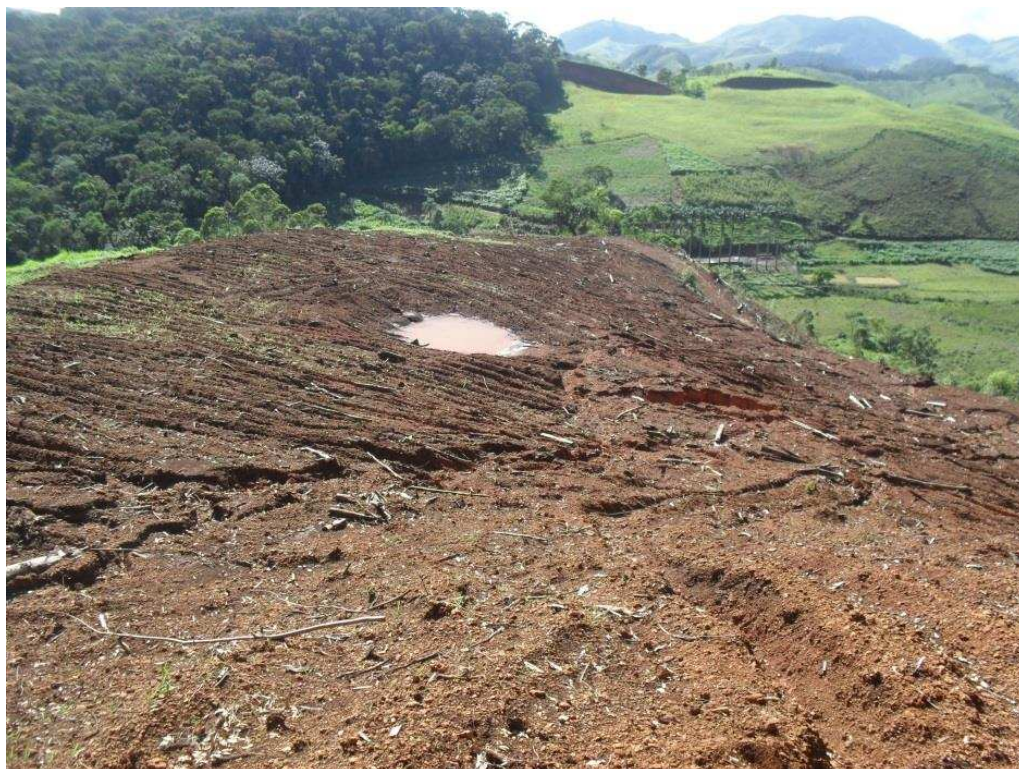
Figura 38 - Barragem construída em local inadequado. São Sebastião da Vargem Alegre-MG,2017.
