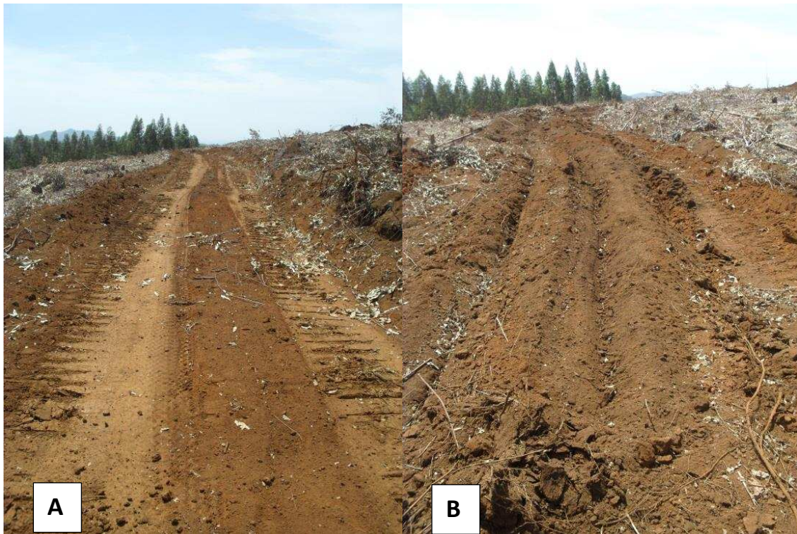
Figura 11 - Etapas executadas após o corte do eucalipto. A) Estrada de acesso para a retirada da madeira. B) Estrada escarificada após a retirada da madeira. Rosário da Limeira-MG, 2017.
