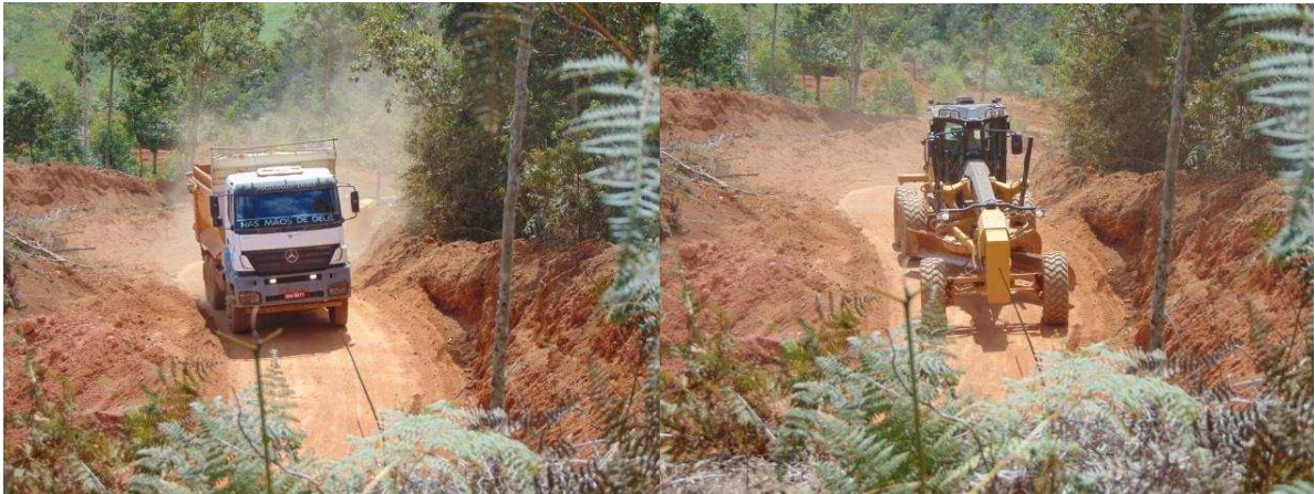
Figura 15 - Áreas de exploração da bauxita com emissão de particulados pela movimentação de caminhões e máquinas. Rosário da Limeira-MG, 2017.
