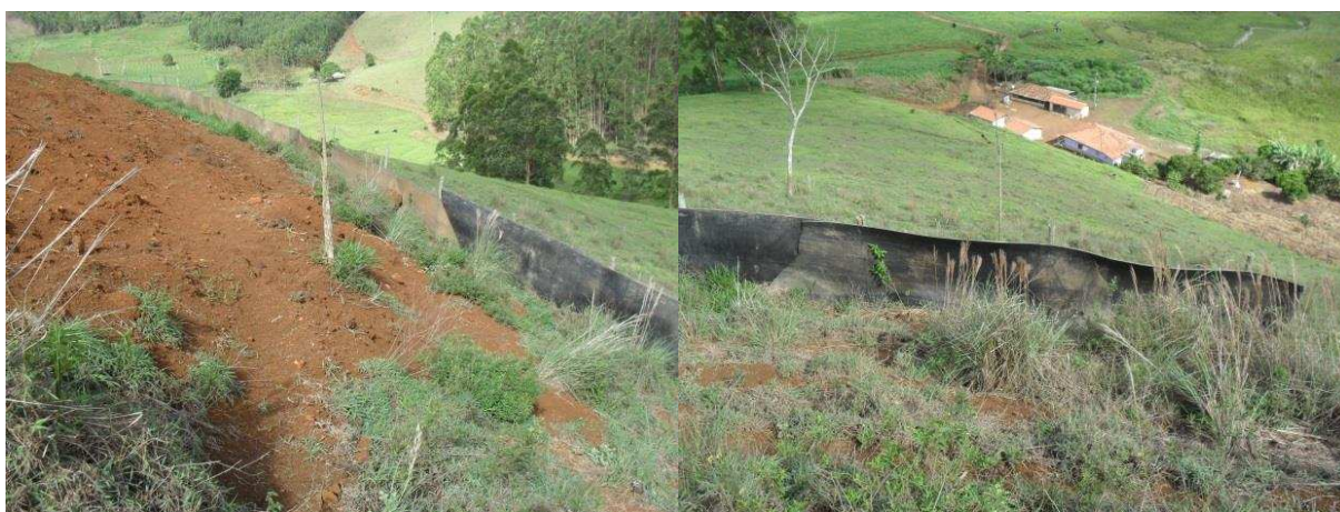
Figura 19 - Uso de correias transportadoras para contenção de material sólido em áreas de exploração de bauxita. Rosário da Limeira-MG, 2017.
