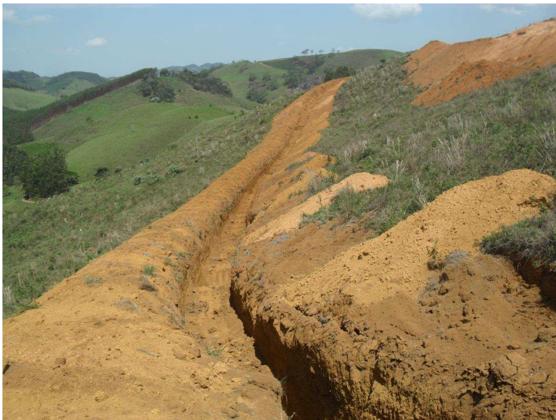
Figura 21 - Trincheira para retenção de água de escoamento superficial e material sólido em área de exploração de bauxita. São Sebastião da Vargem Alegre-MG, 2017.
