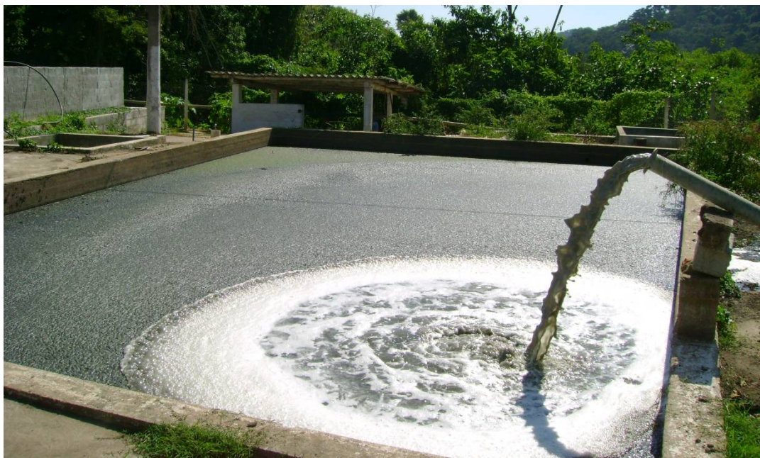
Figura 1.5. Recirculação da ARS no tanque de alvenaria receptor dos efluentes da suinocultura.
