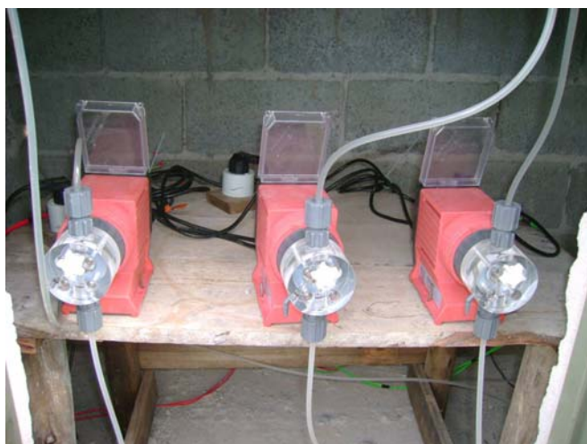
Figura 1.6. Bombas dosadoras a solenóide utilizadas na alimentação dos SACs.
