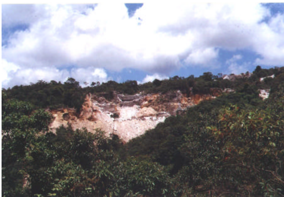
Figura 12: Área de difícil acesso (Ponto não amostrado – Bairro Taquaral).
