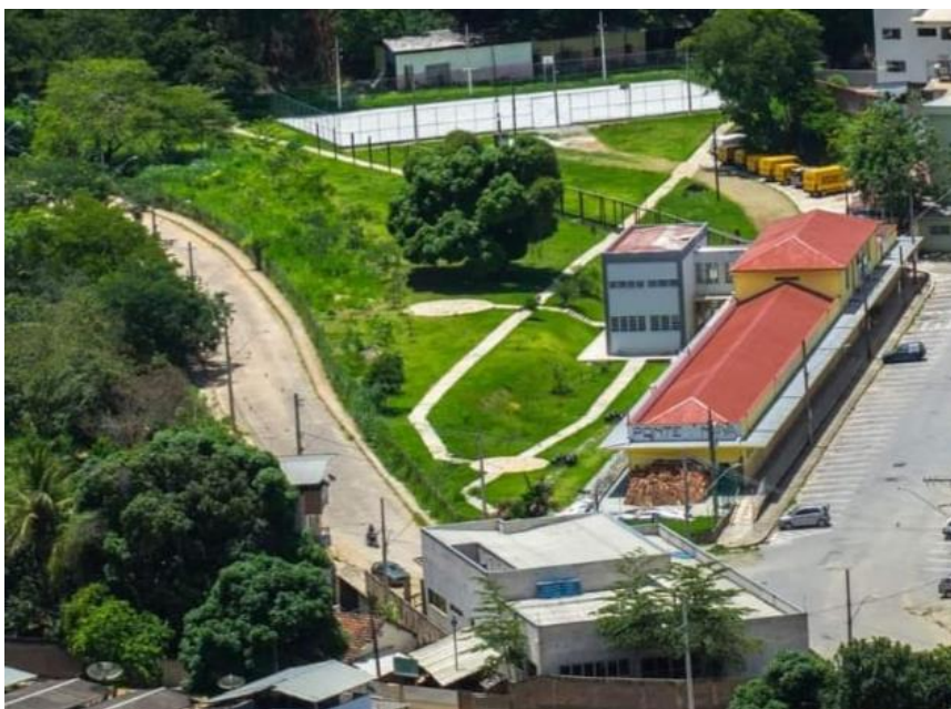
Figura 1 – Campus Avançado Ponte Nova
