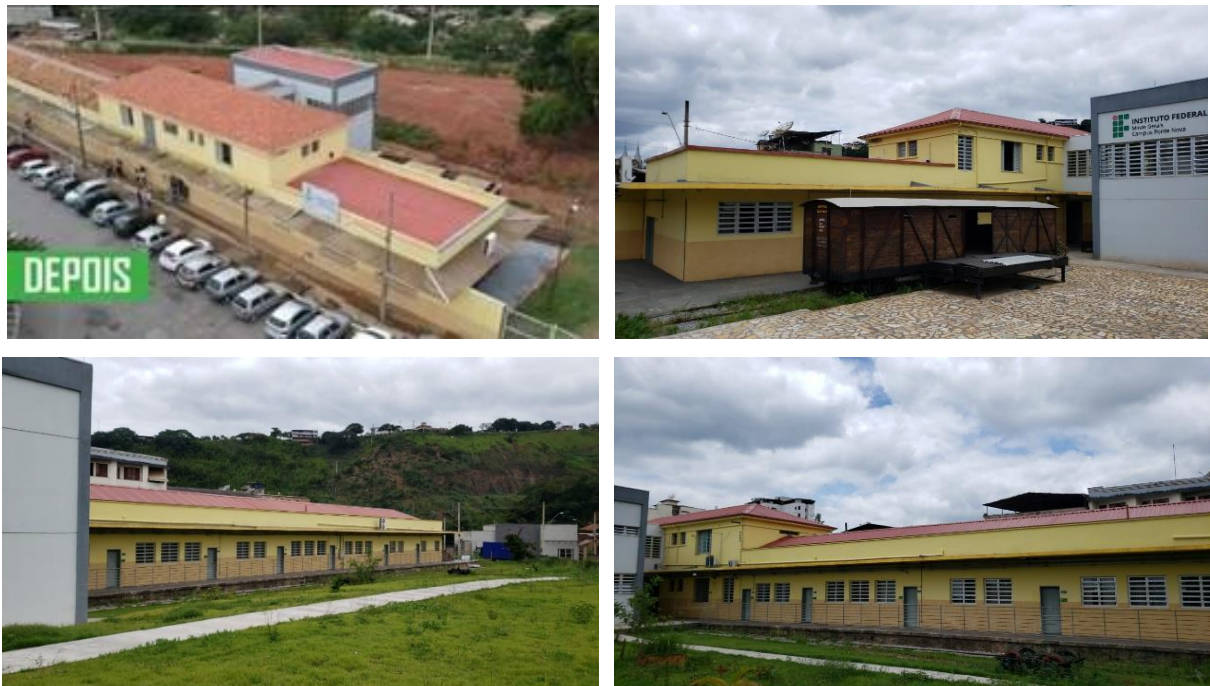
Figura 5 – Prédio do Campus Avançado Ponte Nova depois da reforma
