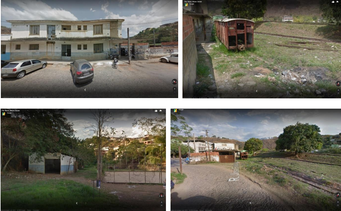
Figura 4 – Prédio do Campus Avançado Ponte Nova antes da reforma
