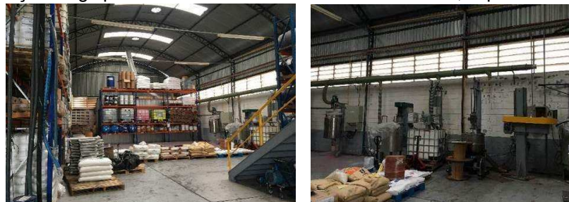
Figura 25 – Iluminação no galpão industrial B: uso de telhas translúcidas, superfícies brancas e janelas.
