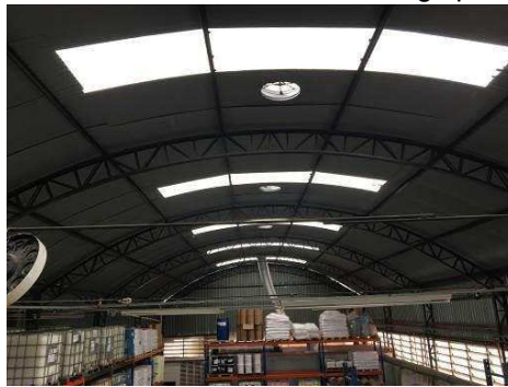
Figura 26 – Vista da cobertura metálica do galpão industrial B.
