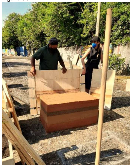
Figura 90: Desenforme da massa solo-cimento
