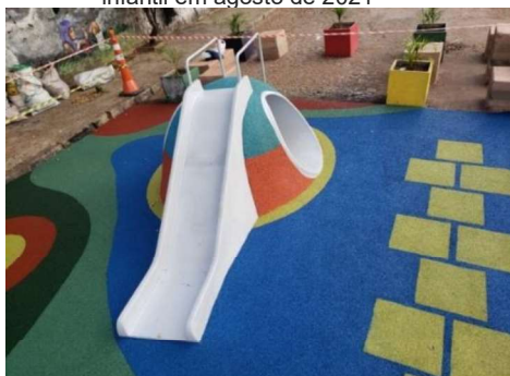
Figura 93: Instalação de piso emborrachado e brinquedo infantil em agosto de 2021
