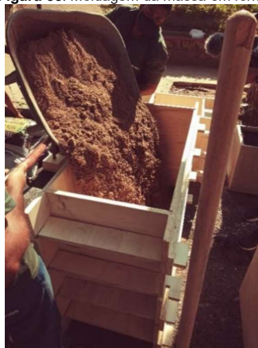
Figura 88: Moldagem da massa em fôrma
