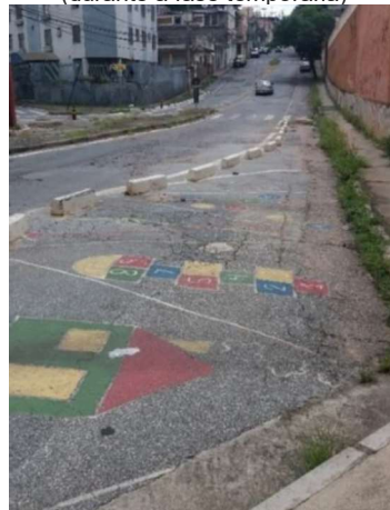
Figura 40: Falta de manutenção do espaço (durante a fase temporária)
