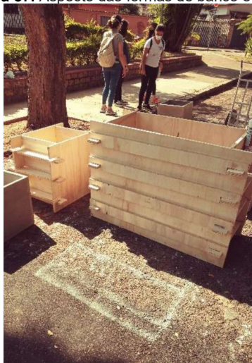
Figura 87: Aspecto das fôrmas de banco e mesa
