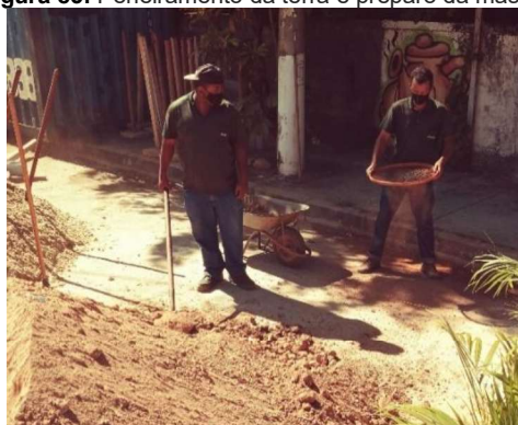
Figura 85: Peneiramento da terra e preparo da massa
