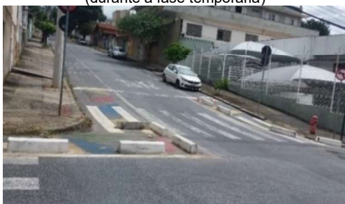
Figura 35: Inserção de segregadores de concreto (durante a fase temporária)
