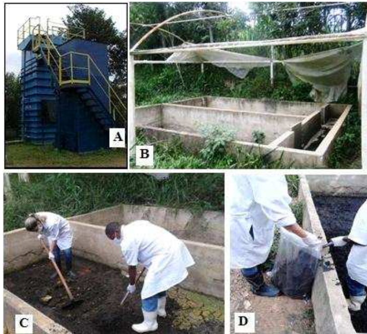
Figura 2: (A) Reator UASB e biofiltro aerado submerso da ETE-Violeira. (B) Leito de secagem adjacente ao reator UASB. (C) Quebra e mistura da camada de lodo de esgoto. (D) Transferência do lodo para saco plástico para o transporte.
