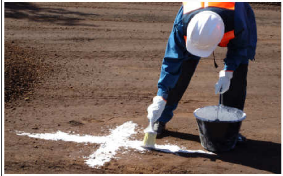
Fig 3.26 - Marcação de ponto de controle no solo.
