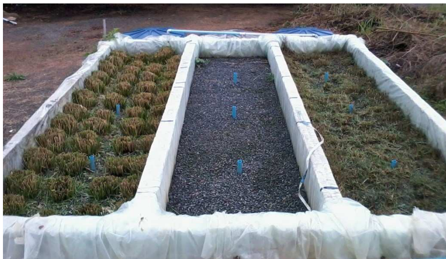
Figura 6. SACs-EHSS utilizados no tratamento de esgoto sanitário.
