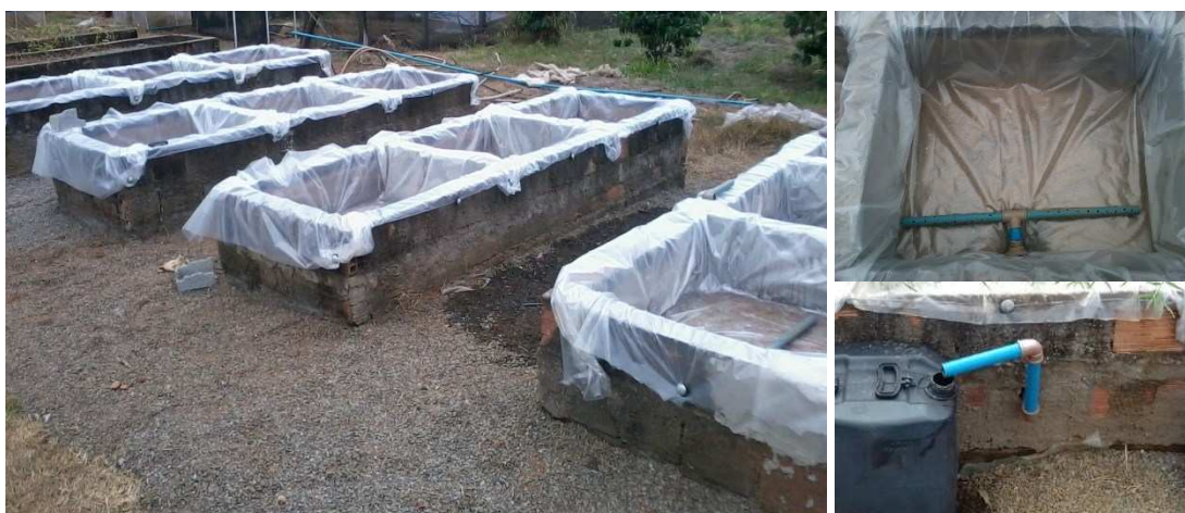
Figura 2. Protótipos de SACs-EHSS construídos para o experimento.
