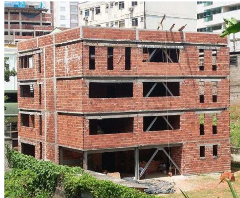
Figura 4.3 - Edifício de ensino da IPV em fase inicial de construção
