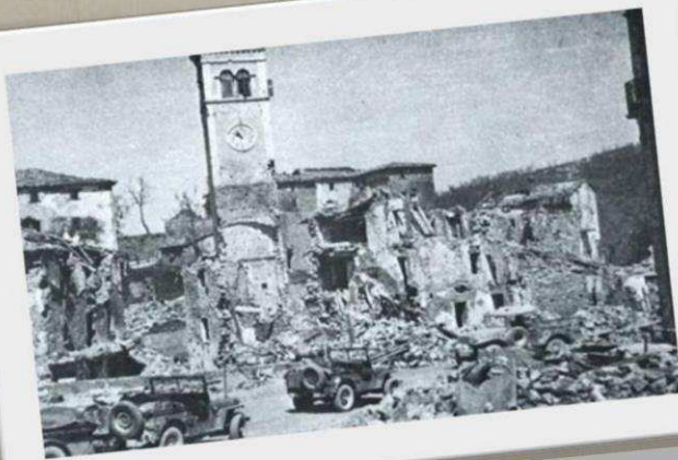
Montese destruída. Fonte: www.eb.mil.br .
