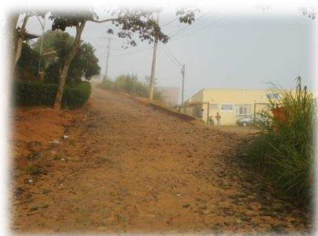
(A): Rua de acesso à UBS
