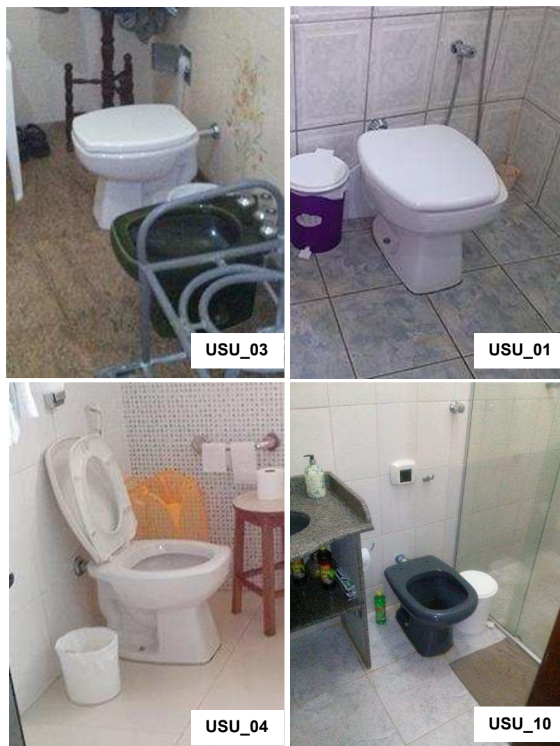
Figura 31 - Vasos sanitários localizados nos ambientes Fonte: Acervo do autor, (2015)
