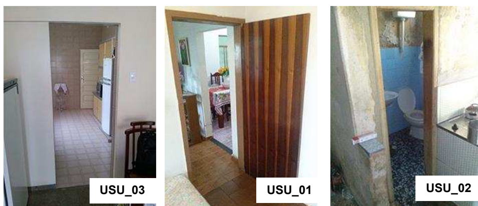
Figura 27 - Portas e entradas localizadas nos ambientes Fonte: Acervo do autor, (2015)
