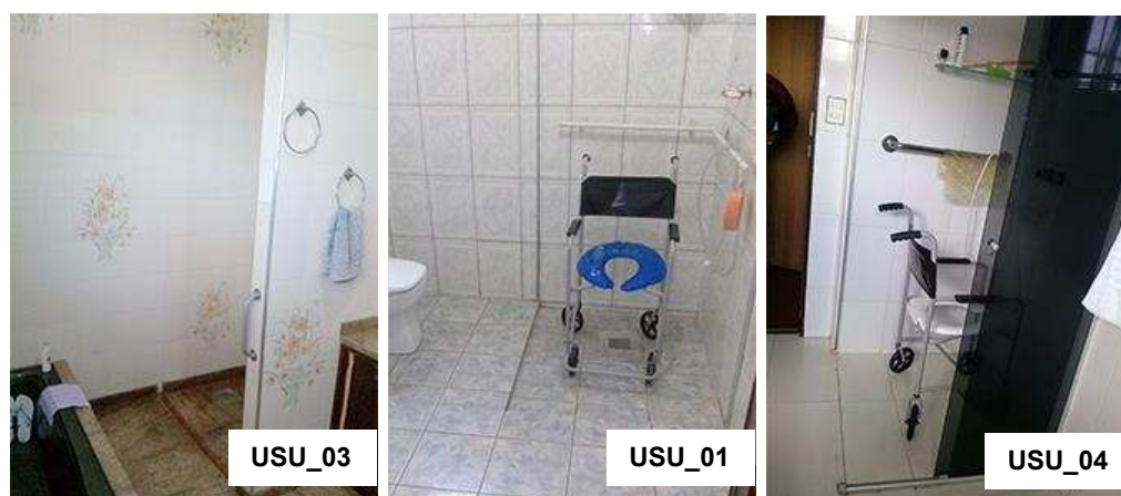
Figura 35 - Boxes de chuveiro dos ambientes Fonte: Acervo do autor, (2015)
