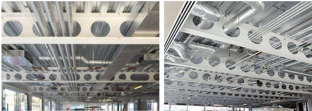
Figura 1.2 – Integração das vigas alveolares com instalações (WESTOK, 2012).
