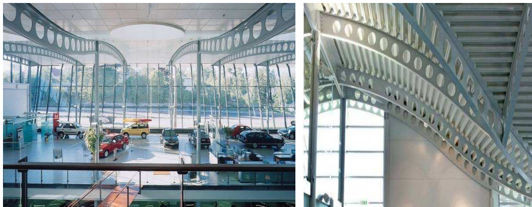
Figura 1.3 – Versatilidade arquitetônica das vigas alveolares (WESTOK, 2012).
