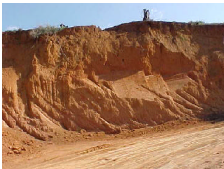
Figura 21 – Talude da rodovia que liga Viçosa a Paula Cândido, próximo à estação de tratamento de água da cidade – Solo ETA
