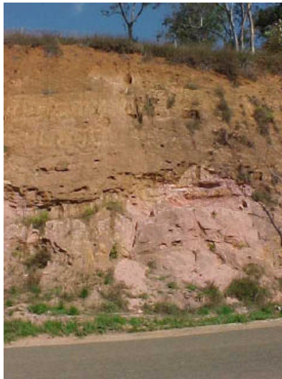
Figura 22 – Talude com corte de mais de 20 metros, situado adjacente à rodovia que liga Viçosa a Paula Cândido, em frente à entrada do bairro Romão dos Reis – Solo SP
