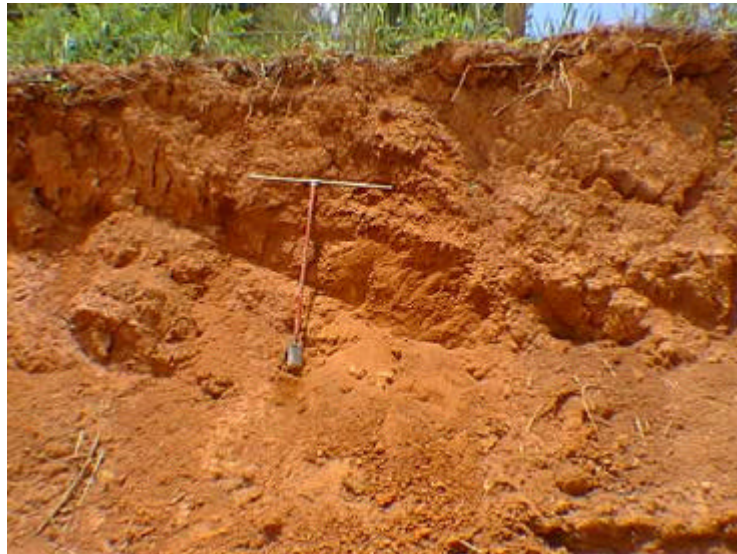
Figura 20 – Talude da estrada que liga Viçosa ao distrito de Palmital – Solo PVB
