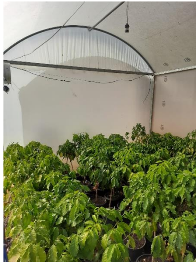
Figura 1 - Interior das estufas com estrutura de ferro galvanizado, fechamento de lona e teto abaulado
