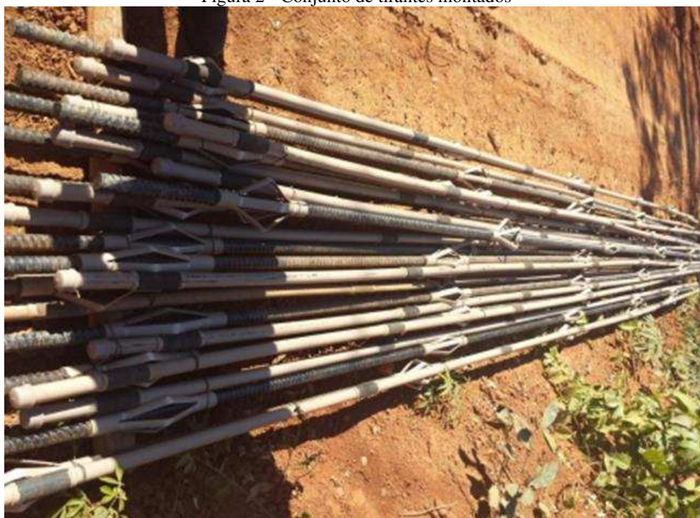
Figura 2 - Conjunto de tirantes montados
