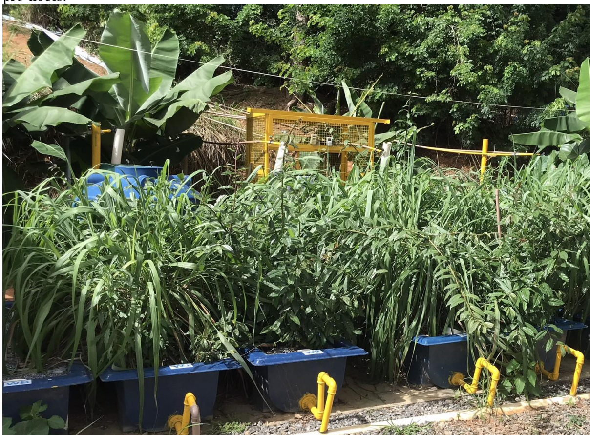
Figura 4.1 – ECTE (ao fundo) e sistemas alagados construídos cultivados com citronela e ora-pro-nóbis.
