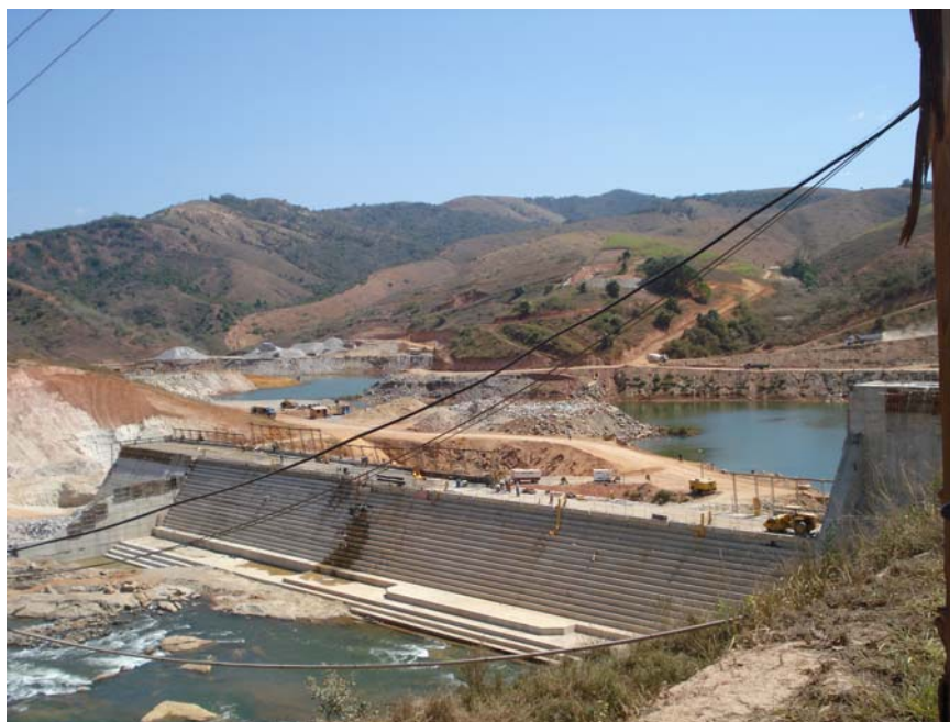
Figura 3: Barragem da PCH Areia Branca em construção.
