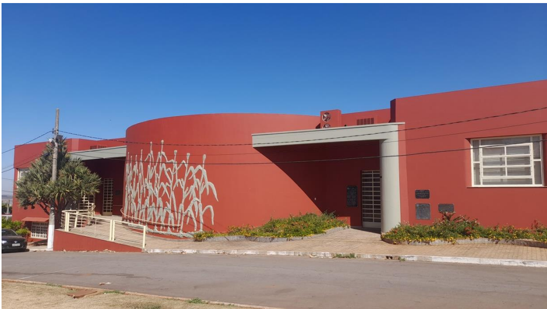
Figura 20 – Vista externa do edifício que abriga o Memorial do Milho, estrutura de mais de 1000 metros quadrados reservada para salvaguardar a memória da Fenamilho e reunir artefatos que remetam à relação do cereal com o município de Patos de Minas.
