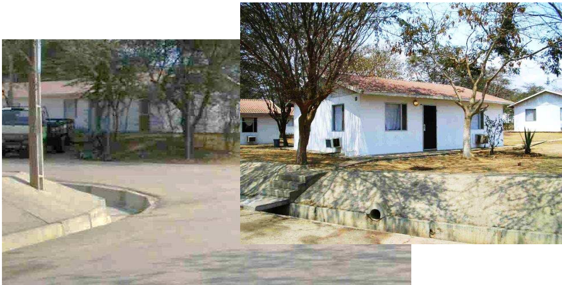
Figura 19 – Sarjeta de um condomínio em Angola
