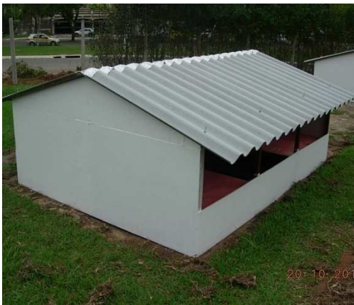
Figura 14 - Vista de um dos protótipos tendo sua cobertura vedada por fita metálica.
