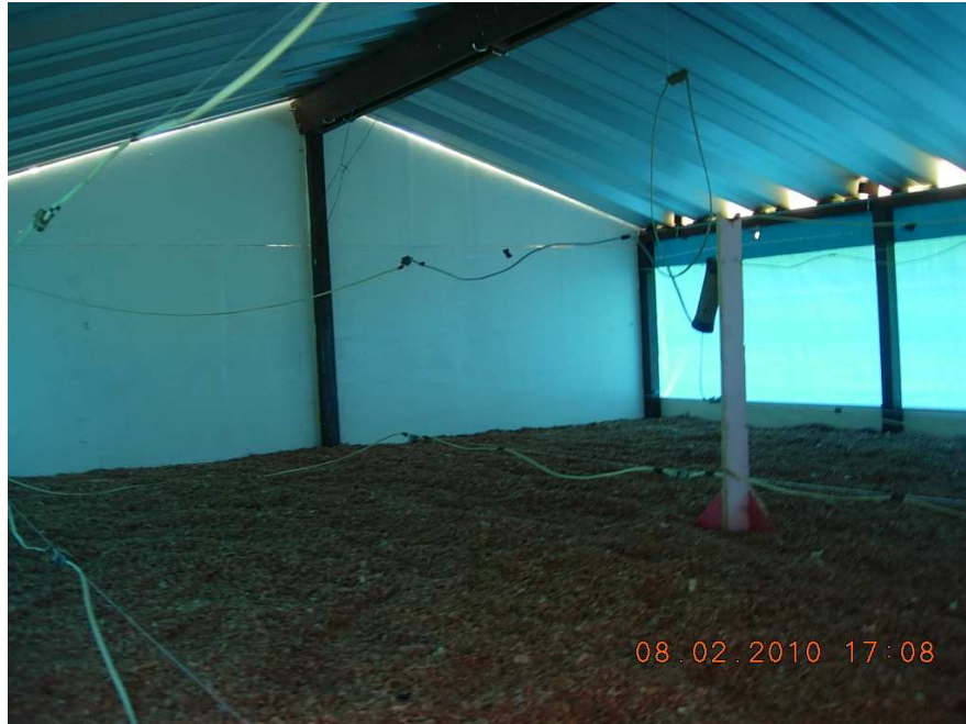
Figura 18 - Protótipo sem a presença de forros sob a cobertura.
