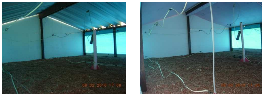
Figura 23 - Vista dos sensores no interior dos protótipos.
