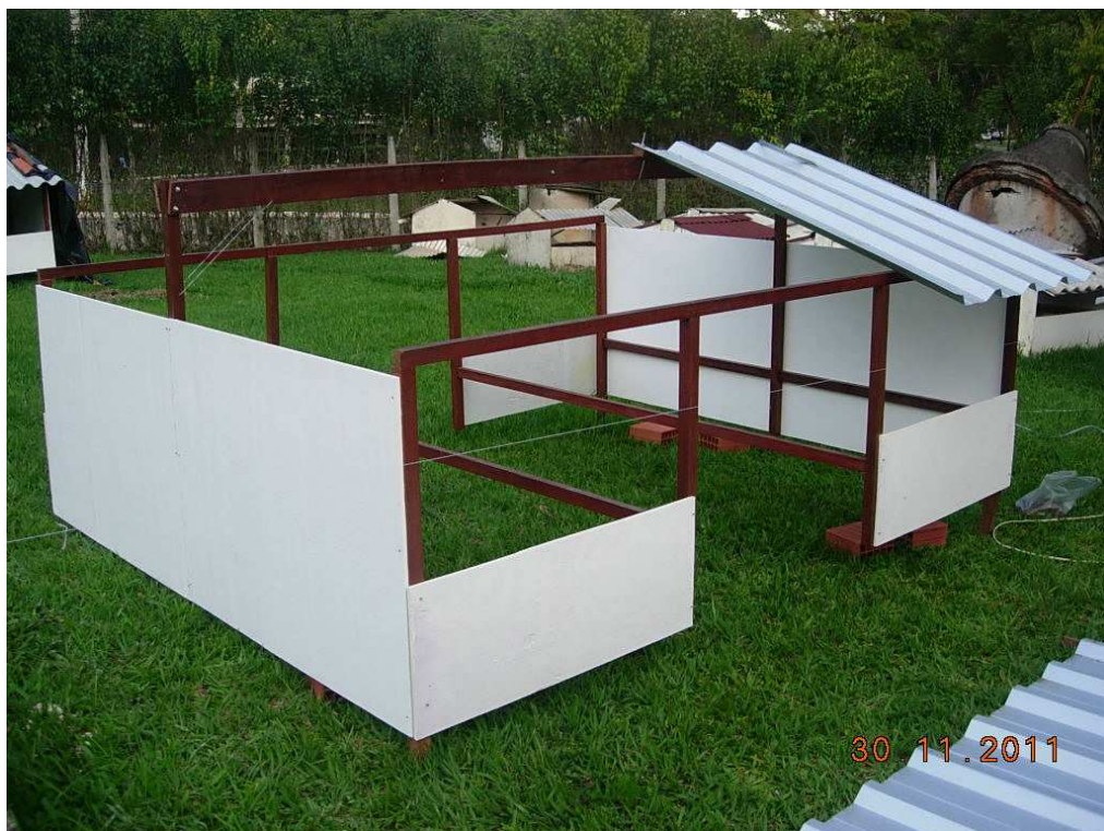
Figura 8 - Protótipo em fase de construção, com estrutura em madeira e fechamento com madeirite.
