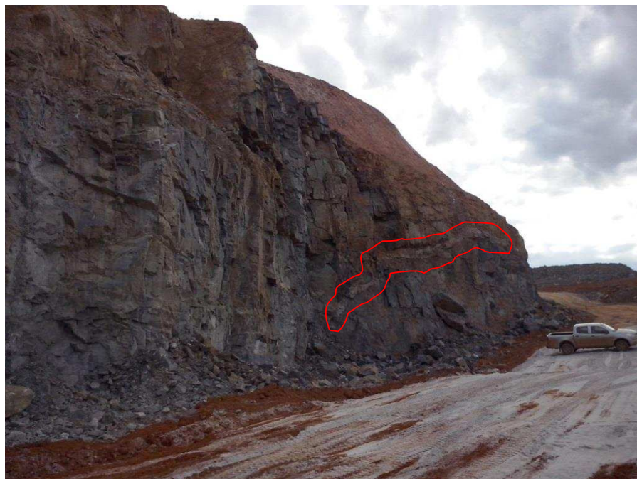
Figura 49: Aspecto estrutural do maciço de anfibolito como rocha encaixante e a intrusão pegmatítica (corpo F, em vermelho) em uma das bancadas da mina.
