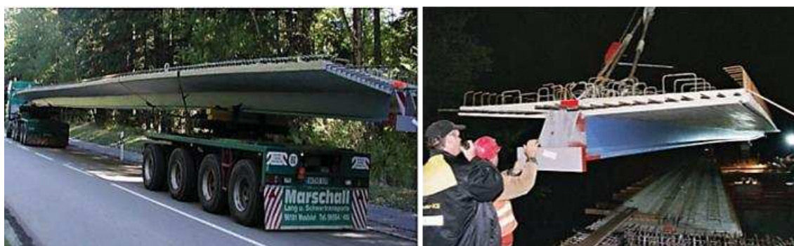
Fig. 2.8 – Estágios da construção da ponte Pöcking Bridge .
