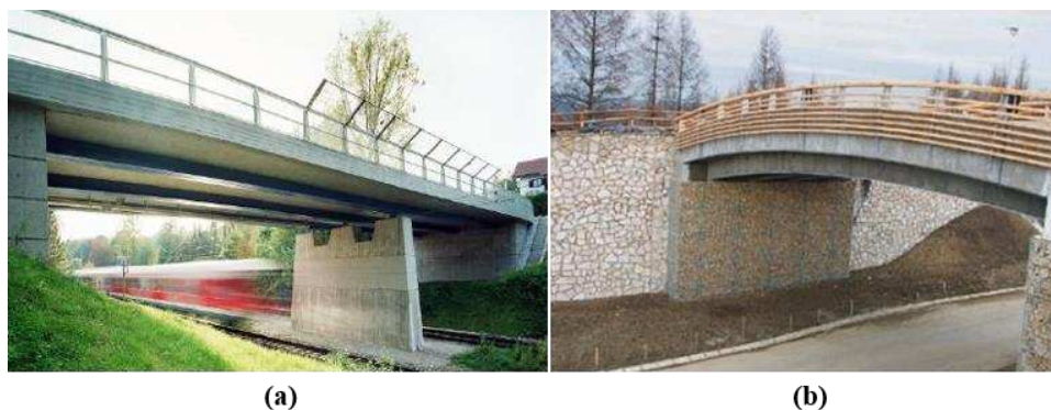
Fig. 2.5 –Pontes com composite dowels : ponte rodoviária sobre a linha ferroviária em Pöcking, Alemanha (a); passarela em Przemysl, Polônia (b).
