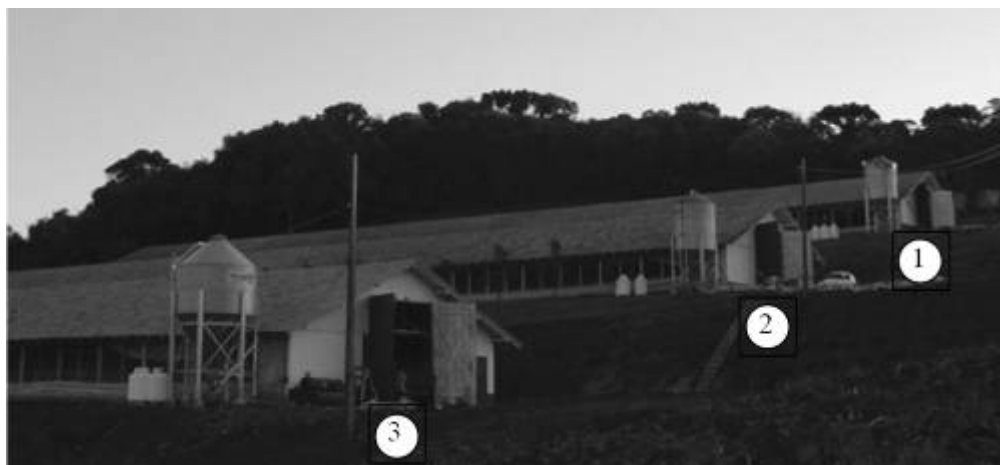
FIGURA 1. Vista geral do núcleo avícola contendo os três galpões criatórios (galpão 1, galpão 2 e galpão 3) utilizados no experimento
